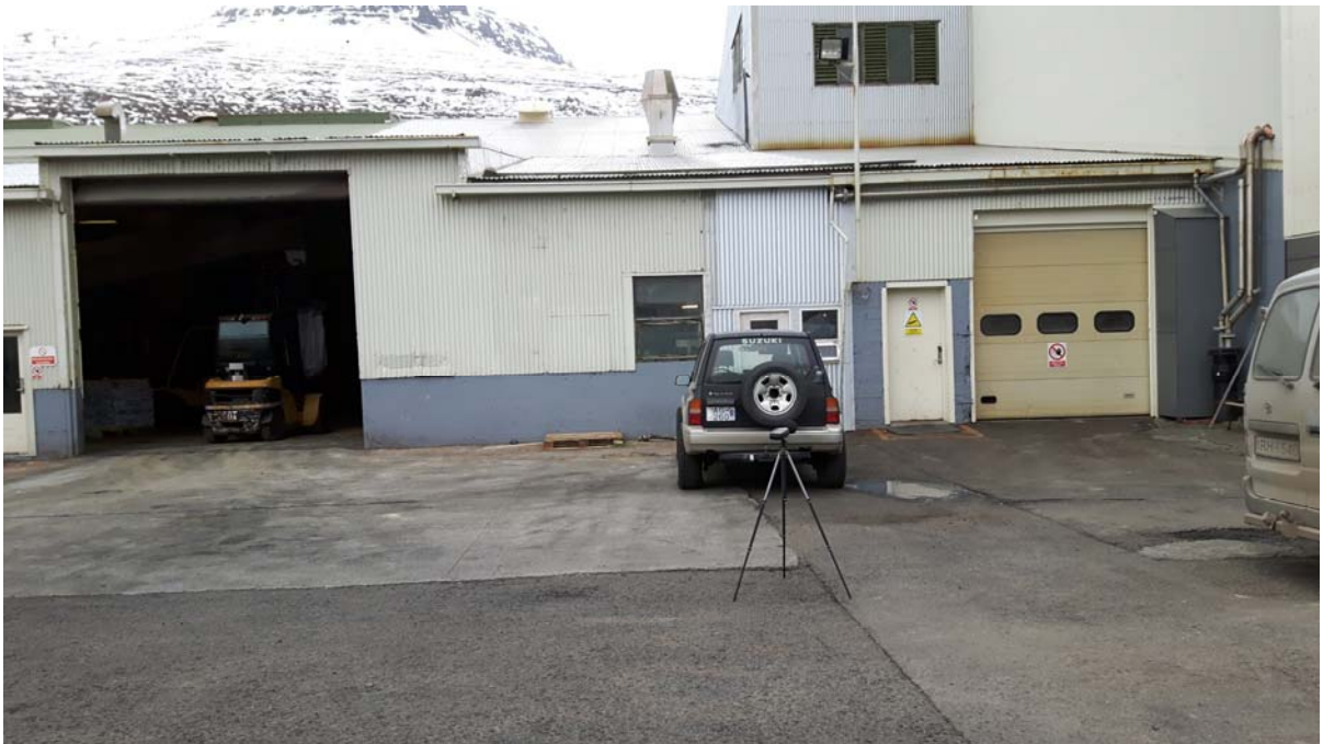
Mynd 10. Mæling 15. Innan lóðar, framan við verkstæði. Suðurhlið verksmiðju.
