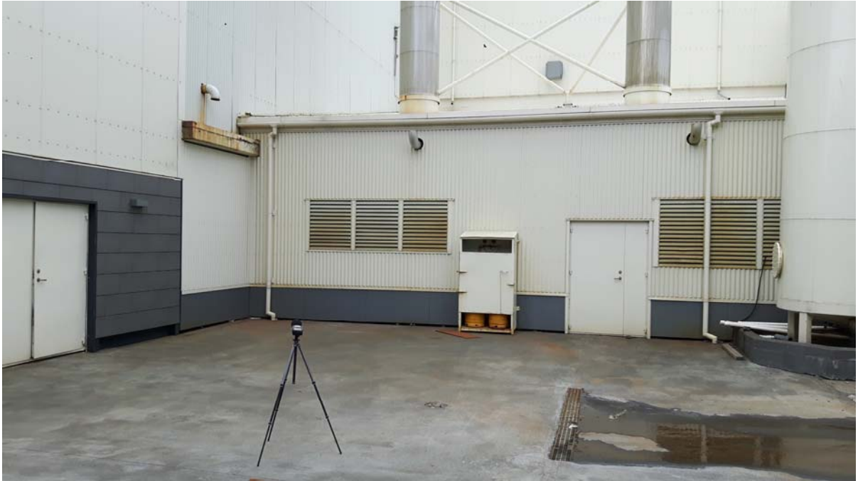
Mynd 9. Mæling 13. Innan lóðar, í porti vestan við skorstein. Suðurhlið verksmiðju.
