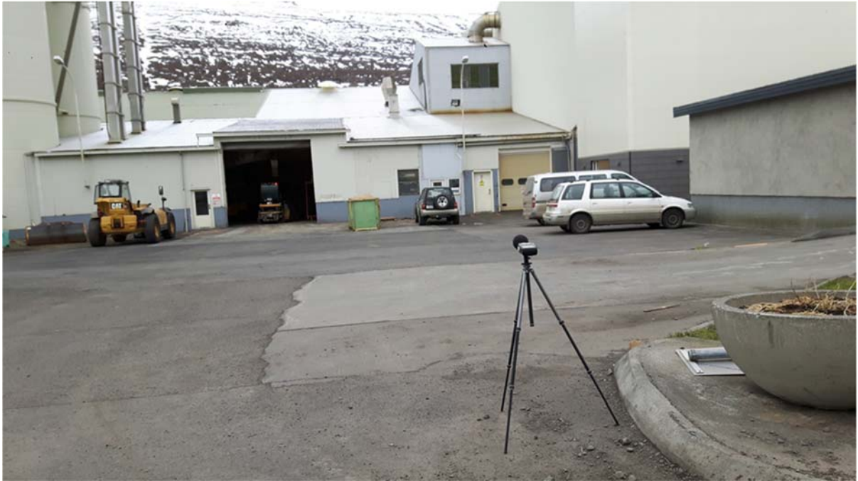
Mynd 11. Mæling 16. Suðurhlið verksmiðju.
