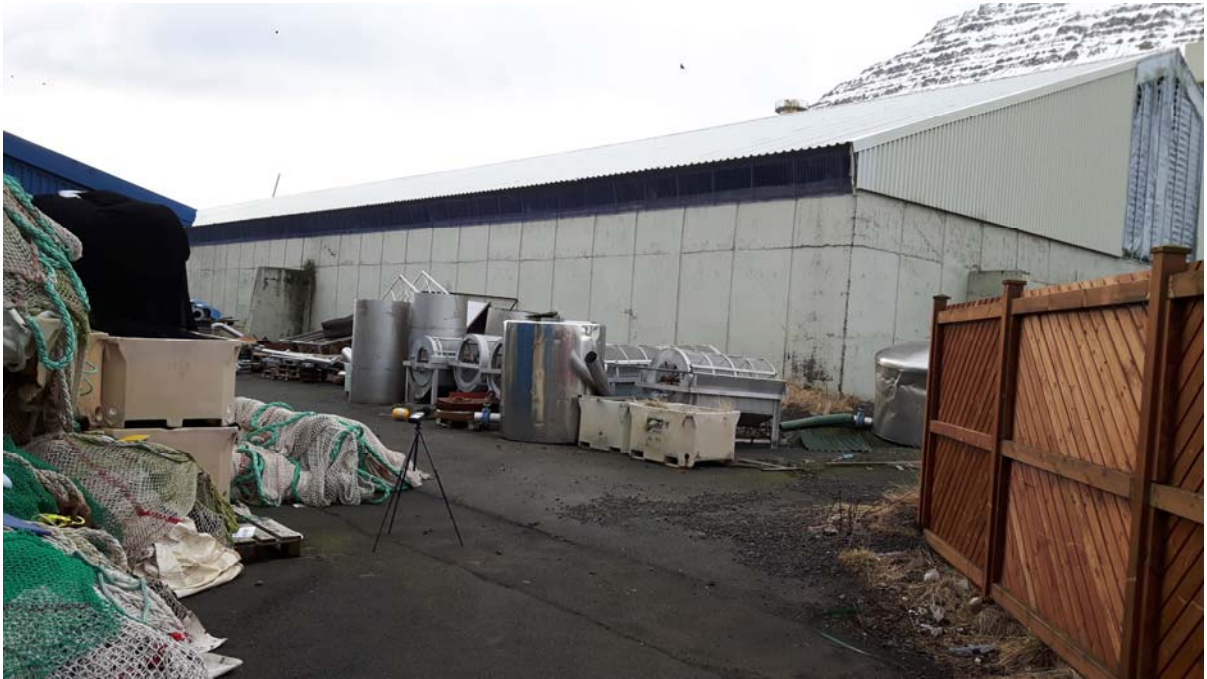
Mynd 7. Mæling 5. Við lóðarmörk NV horn geymslu norðan verksmiðju.
