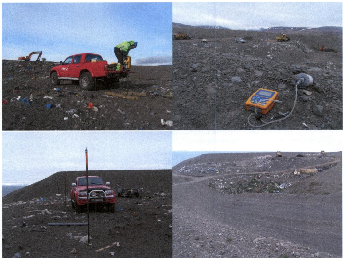
Mynd 2: Niðursetning gasmæliröra og gasmælingar á Stekkjarvík.
