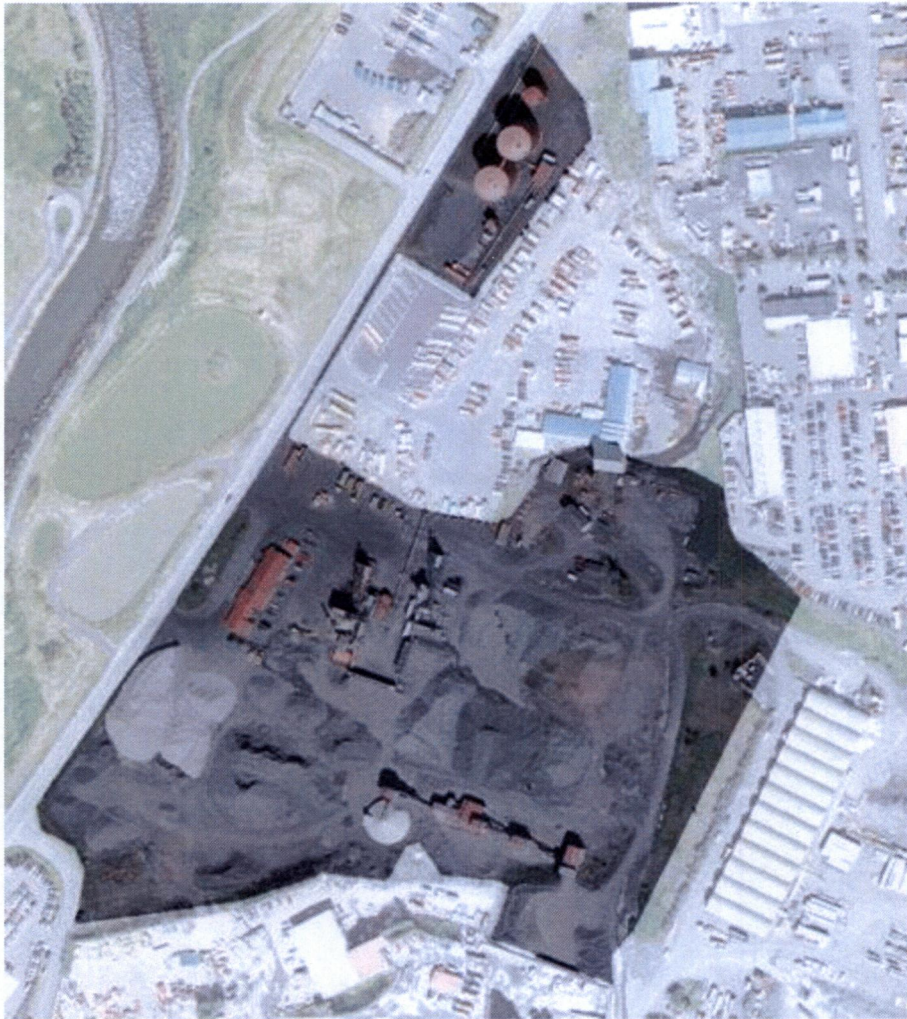
Mynd 1. Yfirlitsmynd af athafnasvæði fyrirtækisins við Sævarhöfða 6-10.
