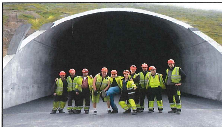
Malbikun Héðinsfjarðarganga lokið haustið 2010
