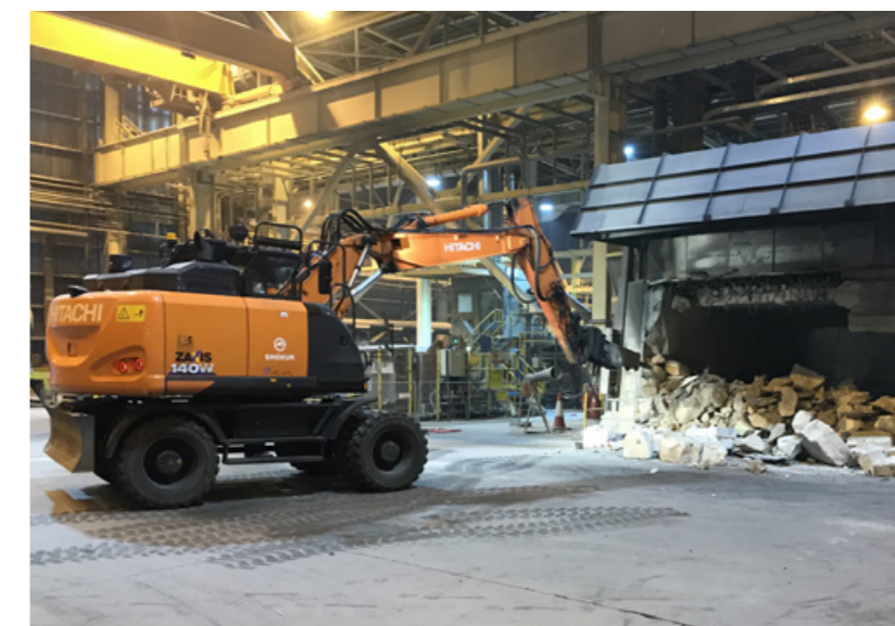
Frá steypuskála: Endurnýjun ofnafóðringa á tveimur ofnum HDC steypuvélarinnar eftir 14 ára notkun. Gamla fóðringin er fleguð úr ofnunum með gröfu.
