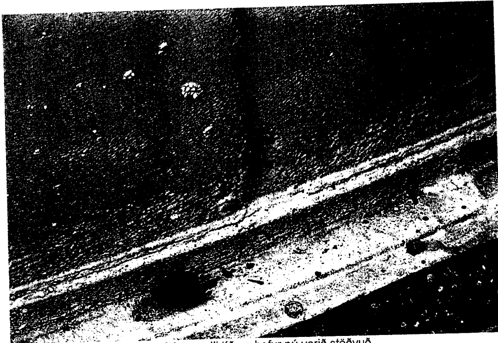
Mynd 13. Ummerki tæringar frá gamalli tíð en hefur nú verið stöðvuð.
