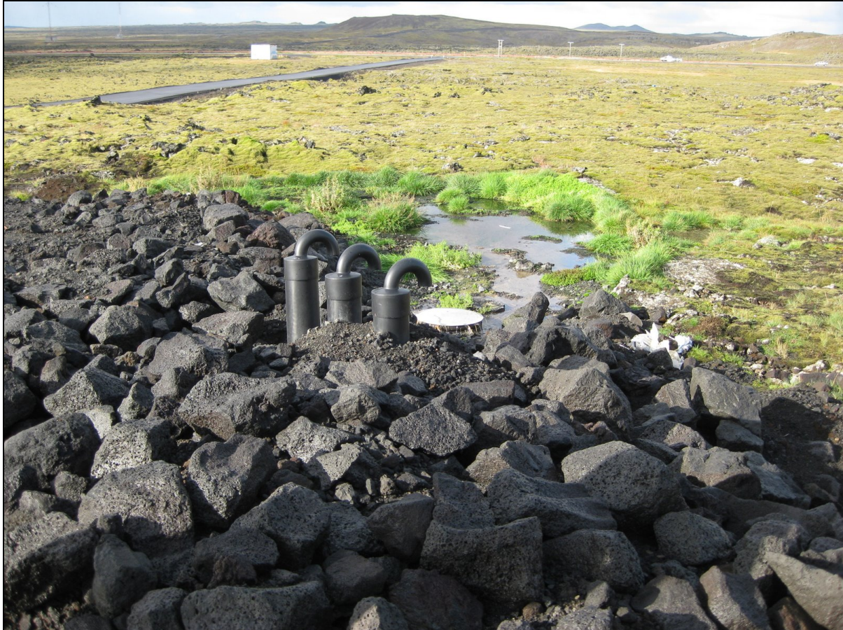
Mynd 13. Siturlögn fyrir frárennsli næringarlausna
