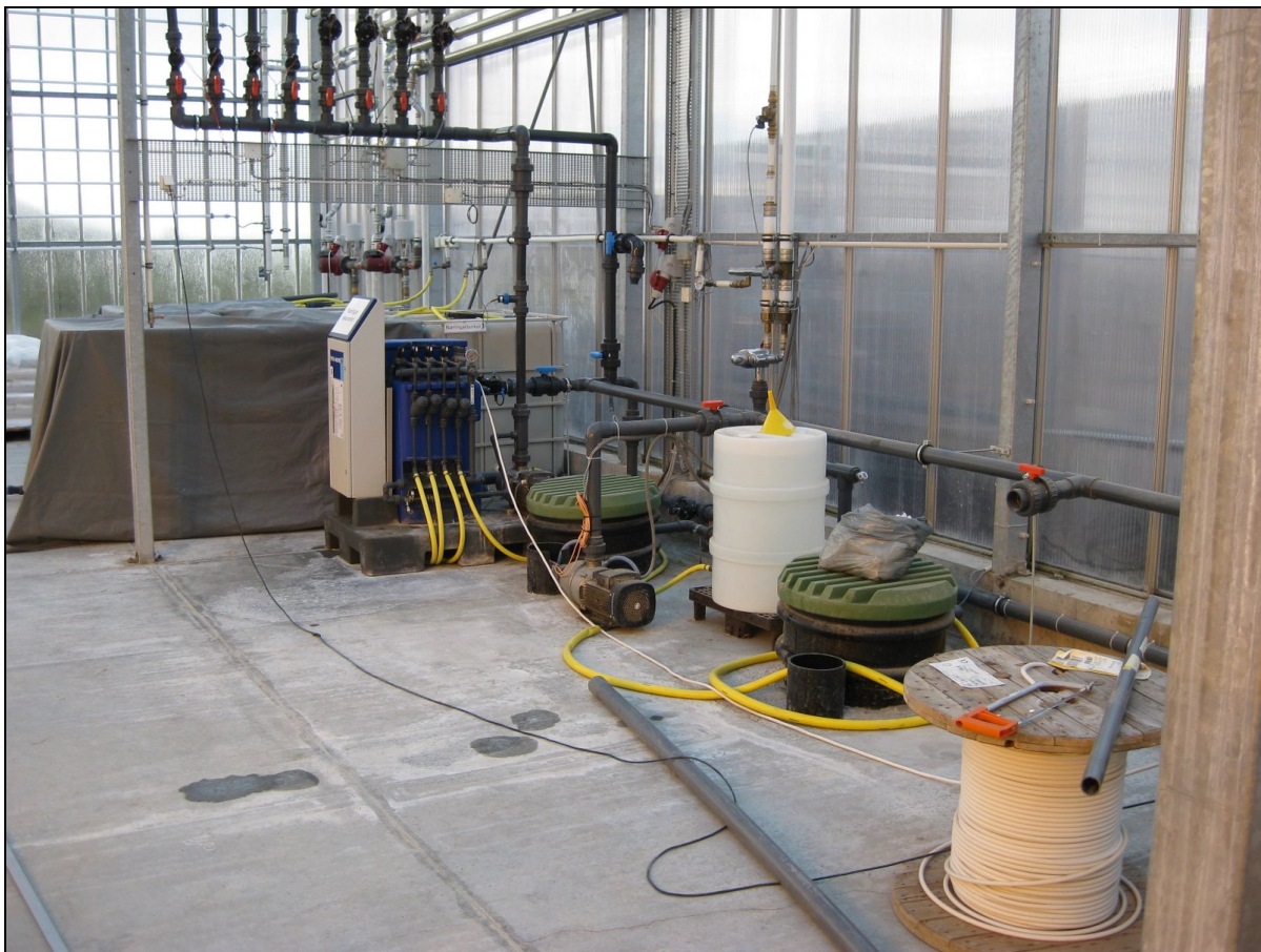
Mynd 12. Aðstaða og tæki fyrir blöndun næringarefna fyrir byggræktunina
