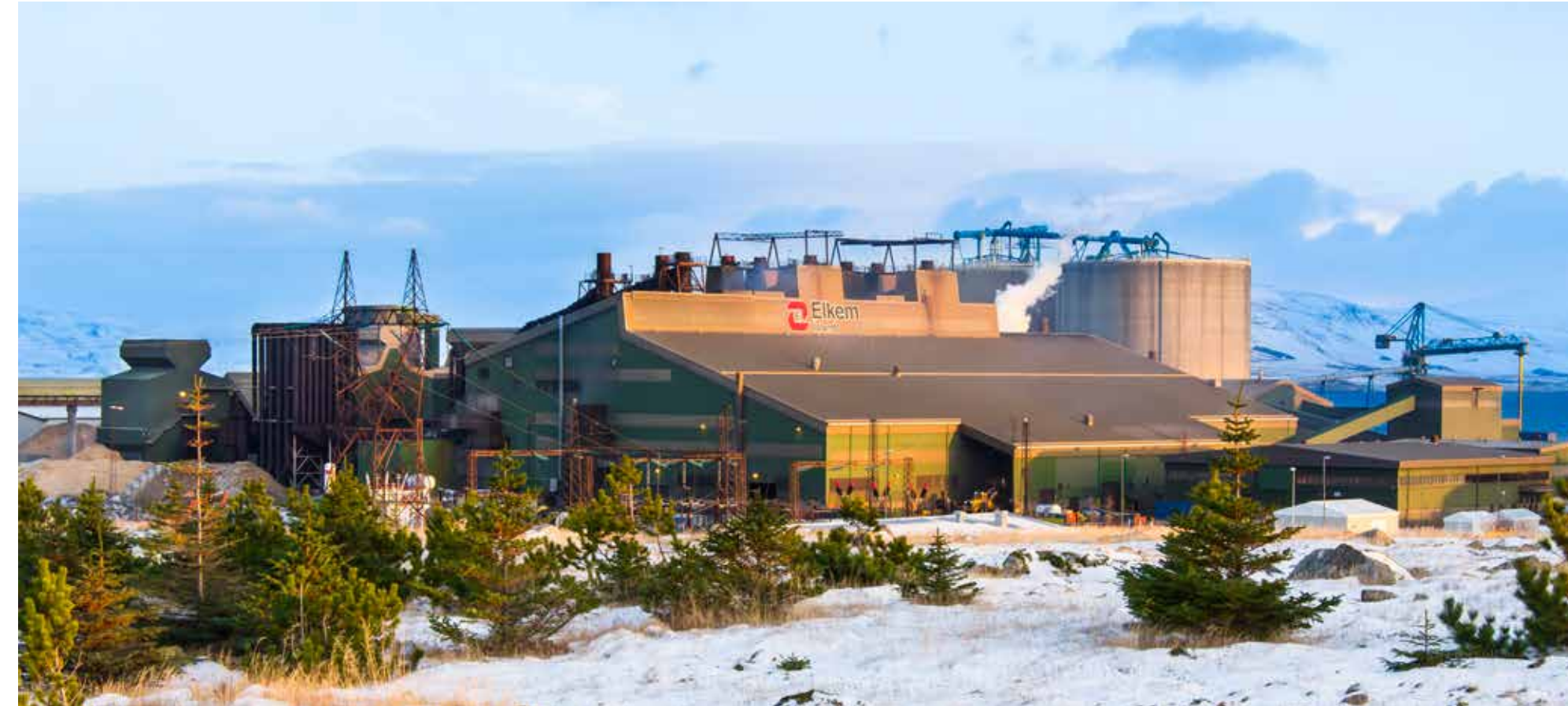
Elkem Ísland uppfyllir allar kröfur sem eiga við um framleiðslu, útblástur, reykhreinsivirki og neyðarreyklos.
