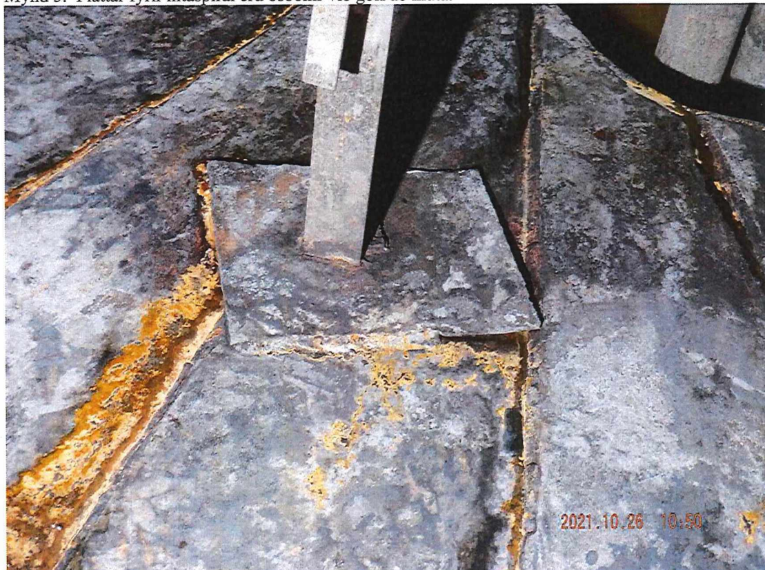
Mynd 6. Plattar fyrir hitaspíral eru ósoðnir við gólf að hluta..
