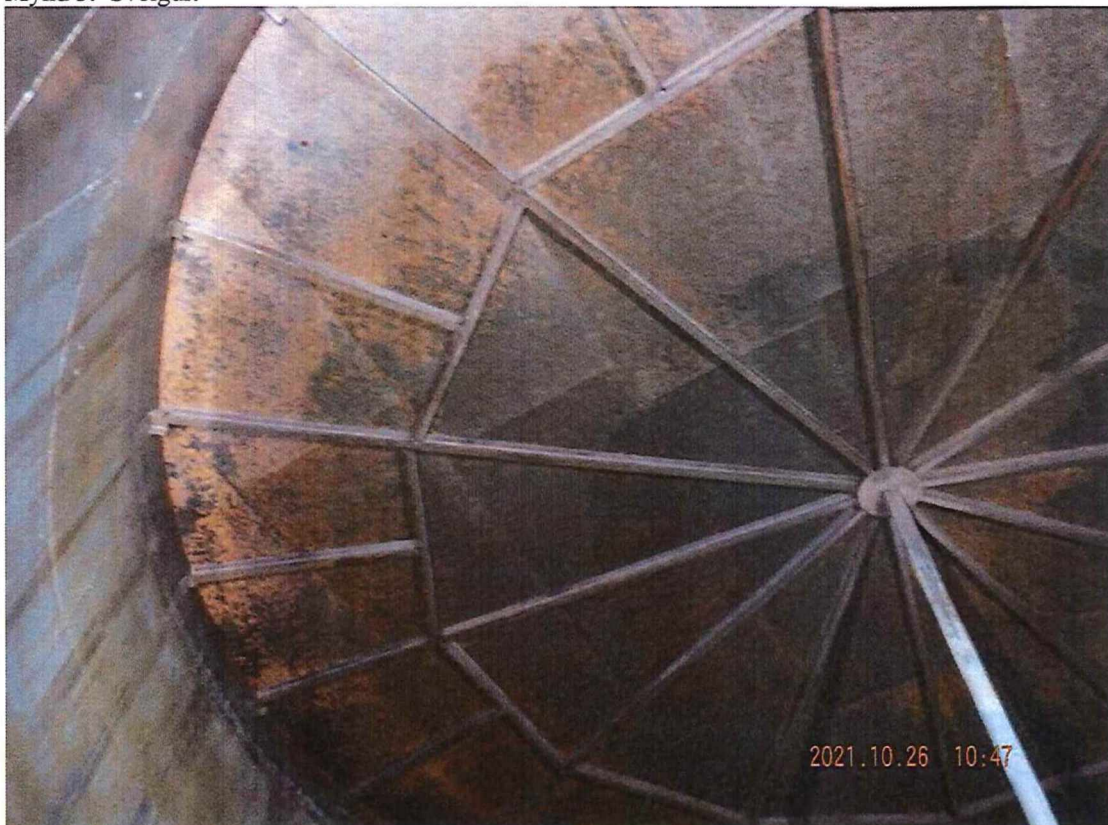
Mynd 4. Þak geymis.
