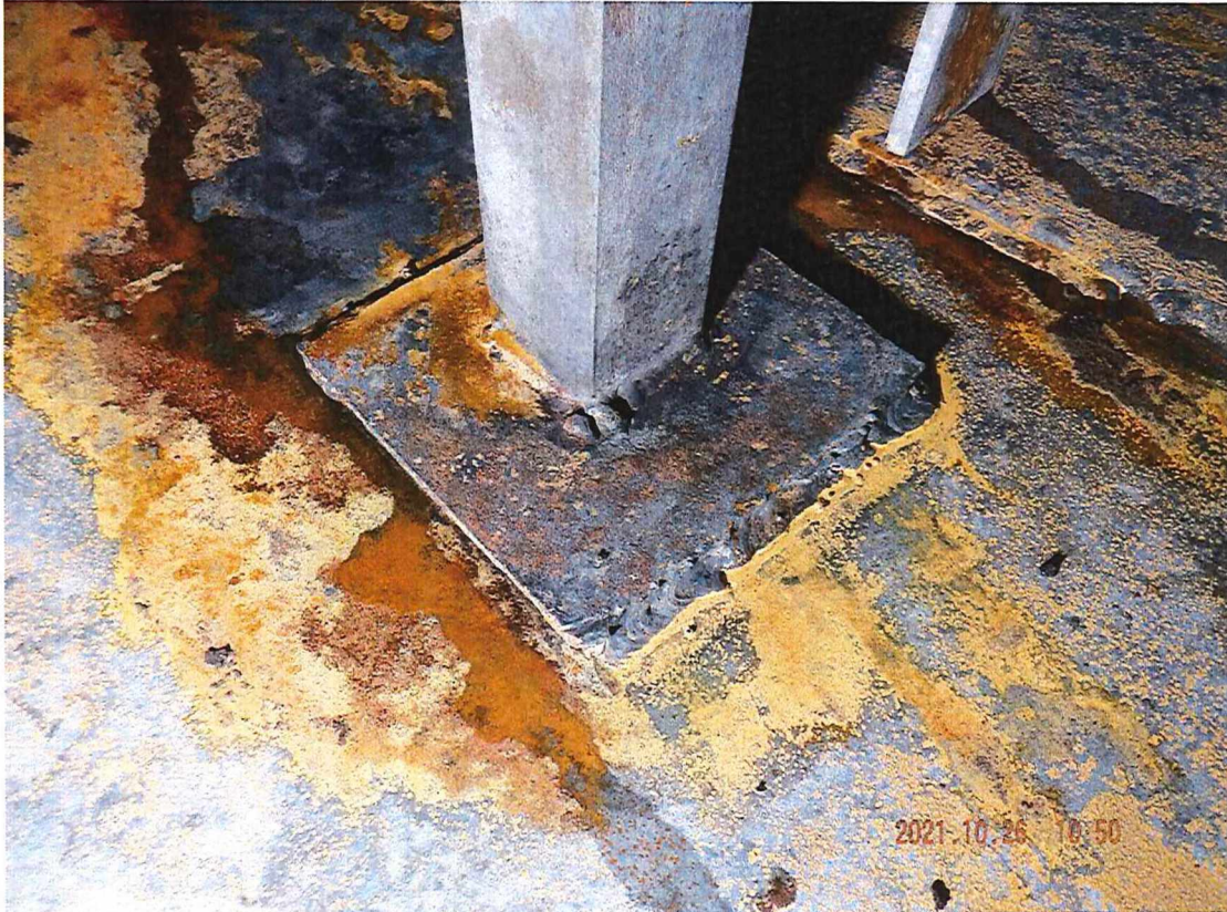
Mynd 5. Plattar fyrir hitaspíral eru ósoðnir við gólf að hluta.
