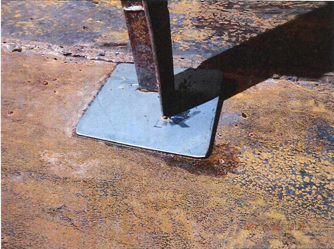
Mynd 5. Plattar fyrir hitaspíral eru ósoðnir við gólf og þar að auki ryðfriir en það getur skapað tæringarvandamál.
