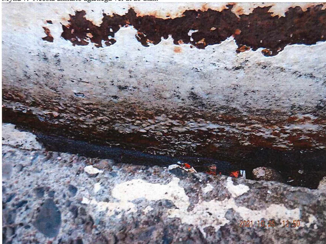
Mynd 8. Ástand málningar er misjafnt við kverk geymis og ryð farið að myndast víða án verulegrar tæringar.
