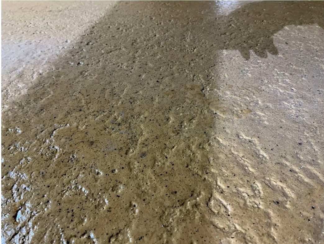
Mynd 3. Gólf er alsett ummerkjum vegna tæringu frá fyrri tíð.
