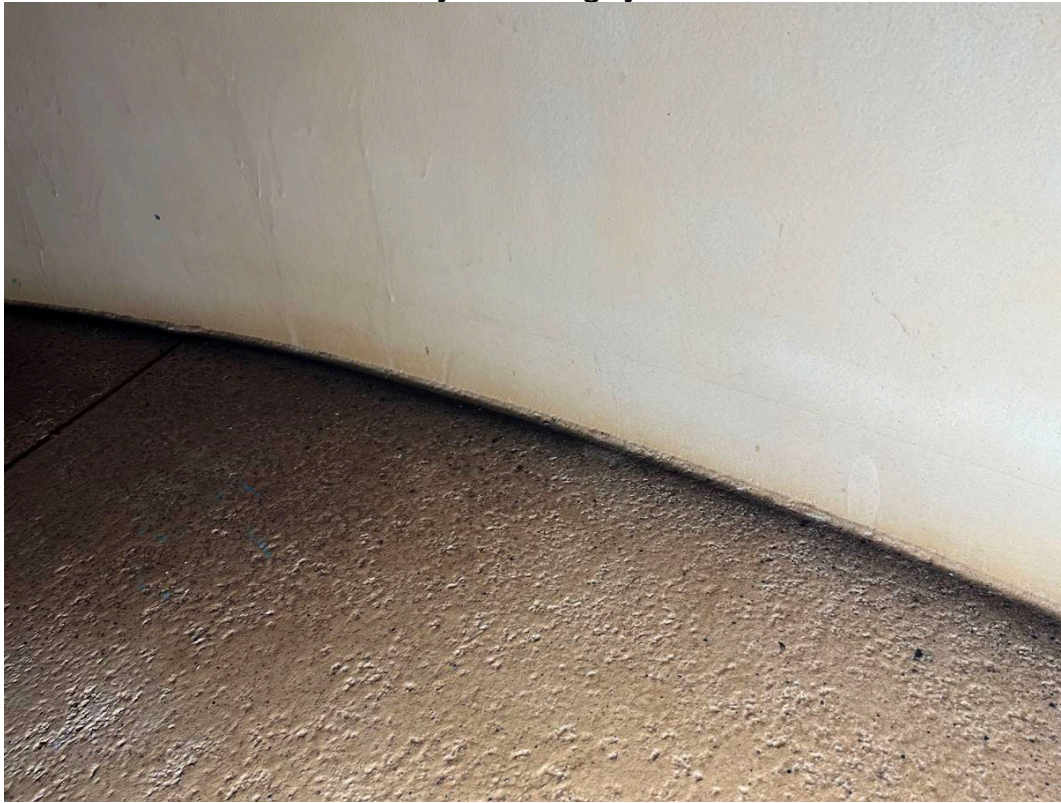
Mynd 1. Gólf geymis og neðsta umfarið er málað.
