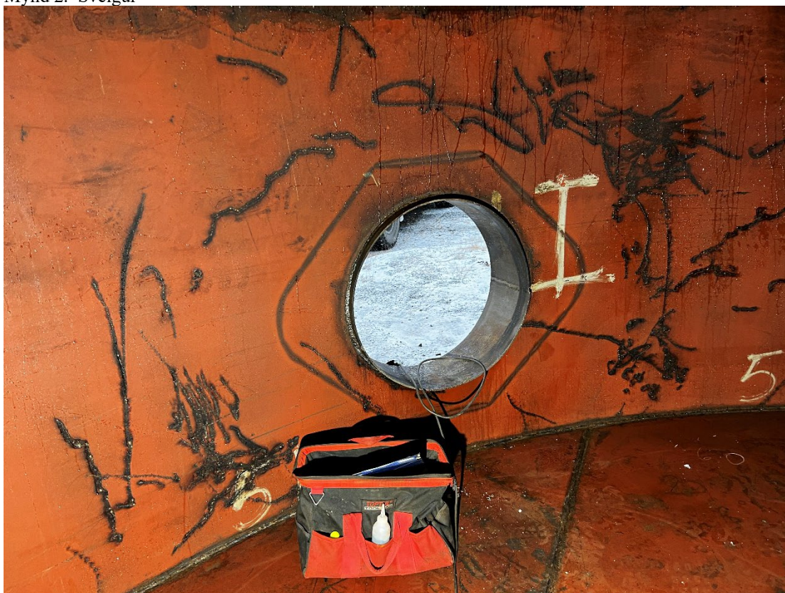
Mynd 3. Rafsuðuvír hefur verið dregin á plötunni, mest við mannopið.
