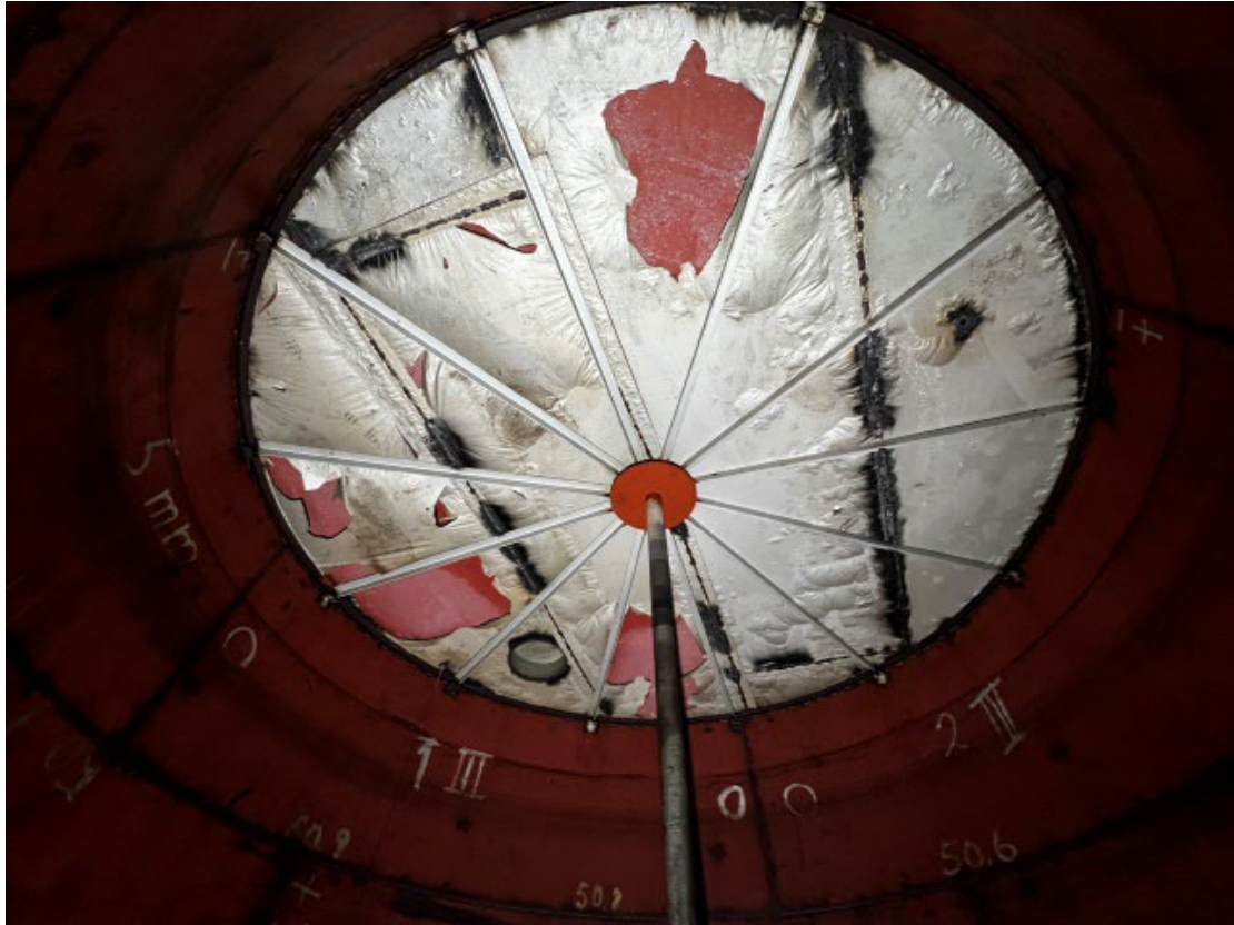
Mynd 3. Þak geymis
