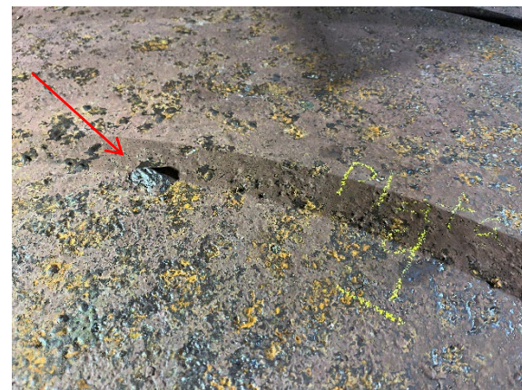
Myndir 1-6. Dæmi um suðupunkta sem eru viðá um gólf og svo tæringu frá fyrri tíð.
