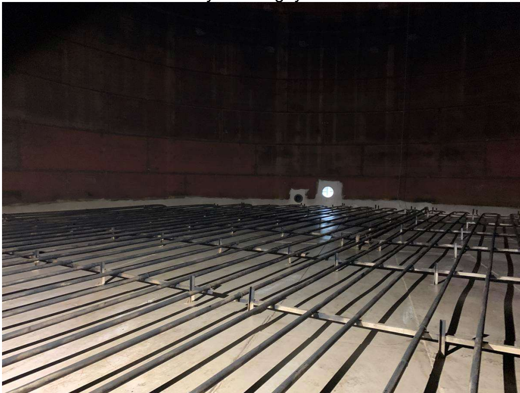
Mynd 1. Búið er að tvöfalda botn víða ( sjá teikn ). Geymir lítur vel út innanvert.
