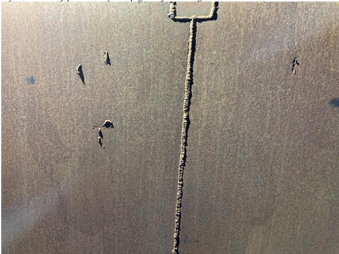
Mynd 10. Ummerki eru víða eftir „verkfæri“ á neðsta umfari geymis.
