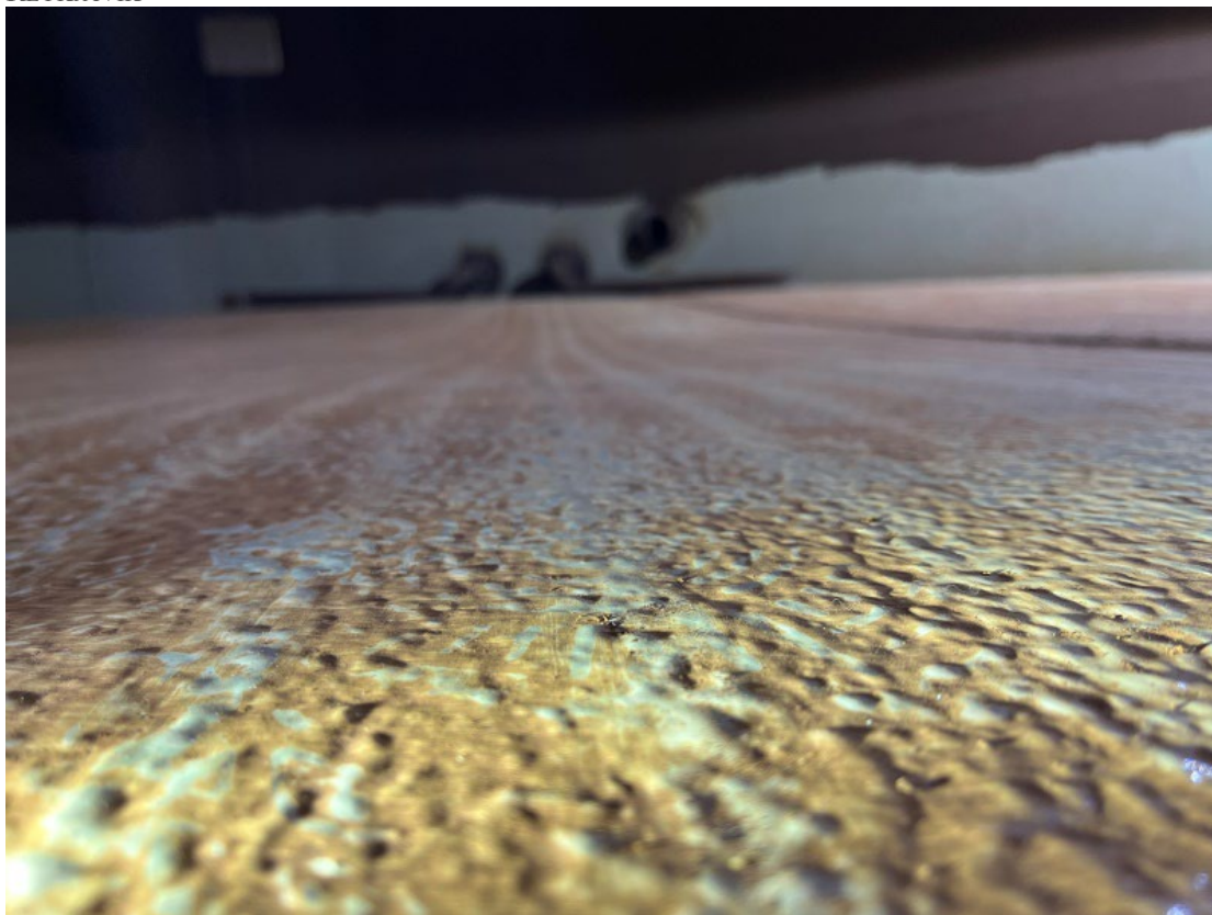
Mynd 7. Málning er alsett bóllum.
