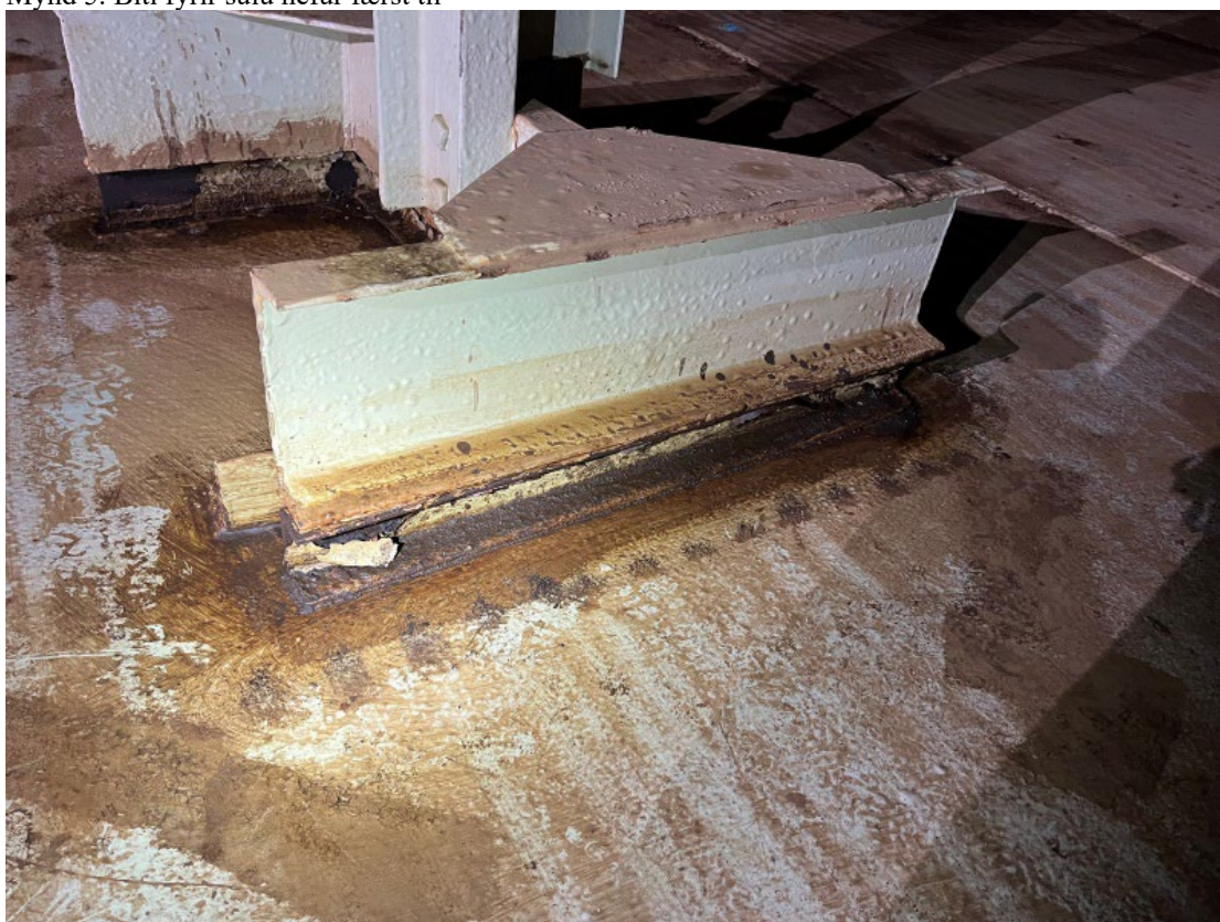
Mynd 6. Biti fyrir súlu hefur færst til
