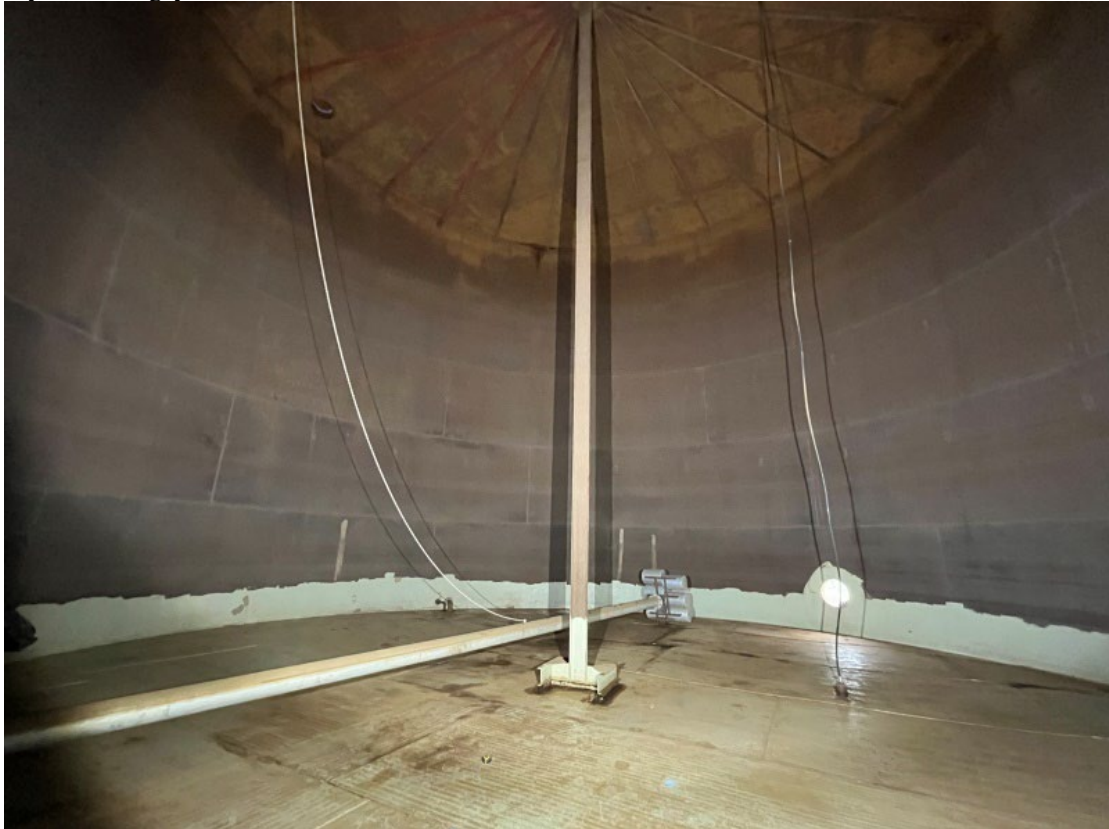
Mynd 2. Gólf og umfar geymis.
