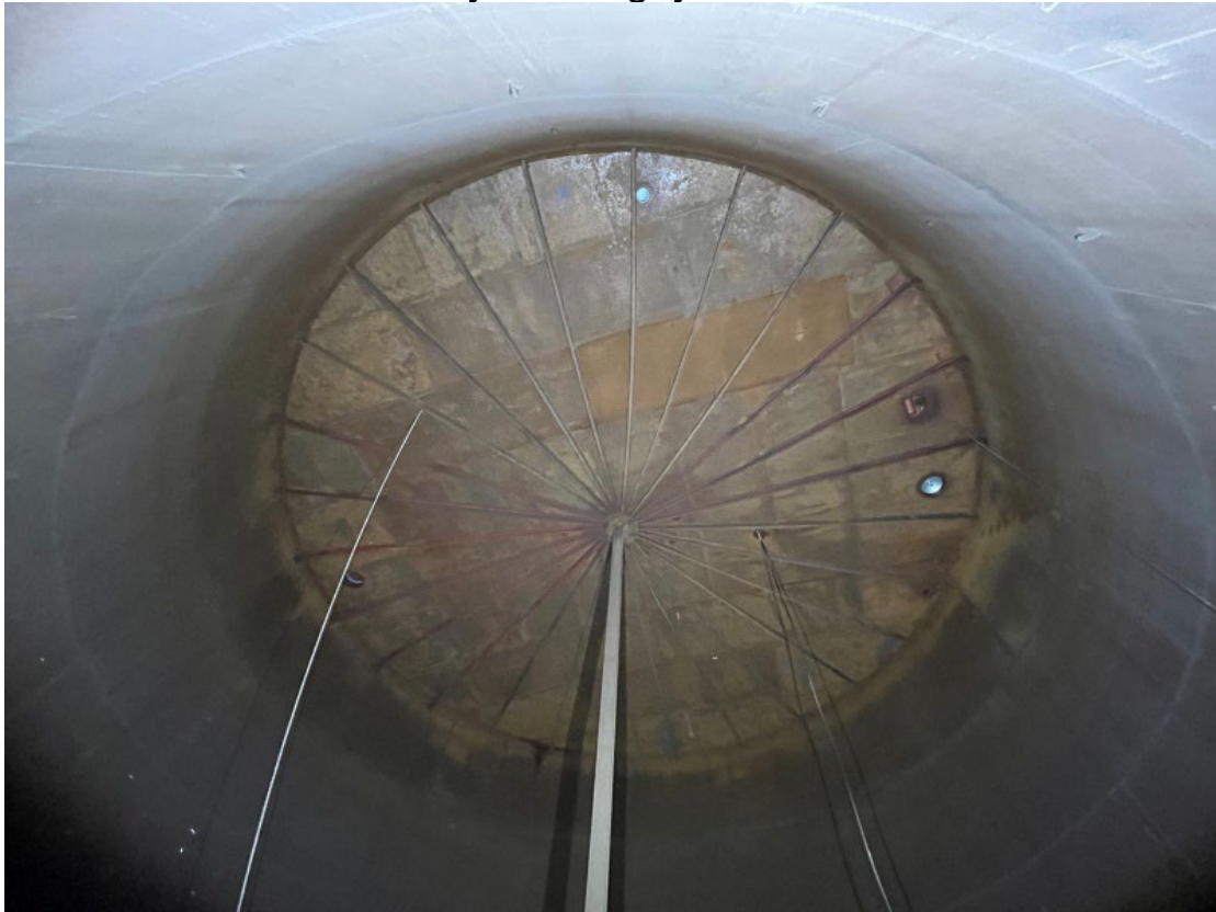
Mynd 1: Þak geymis.
