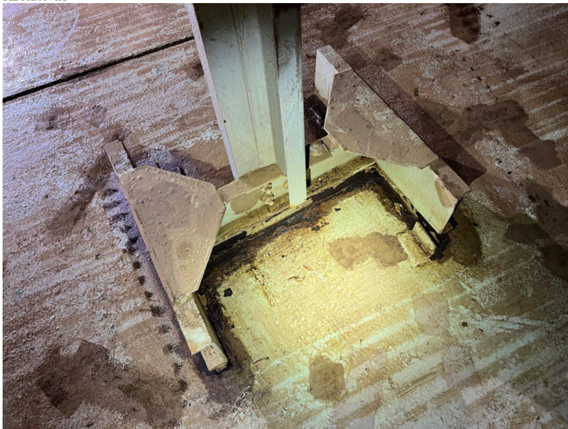
Mynd 5. Biti fyrir súlu hefur færst til
