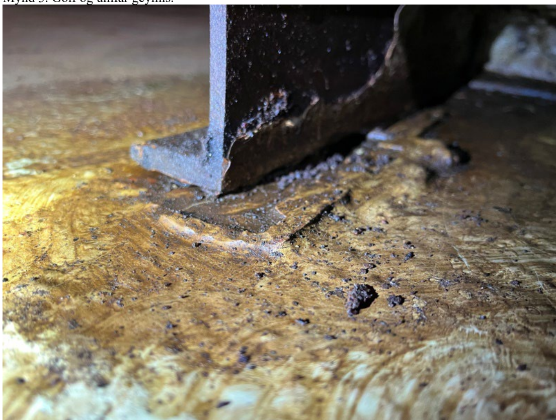
Mynd 4. Biti fyrir súlu hefur færst til
