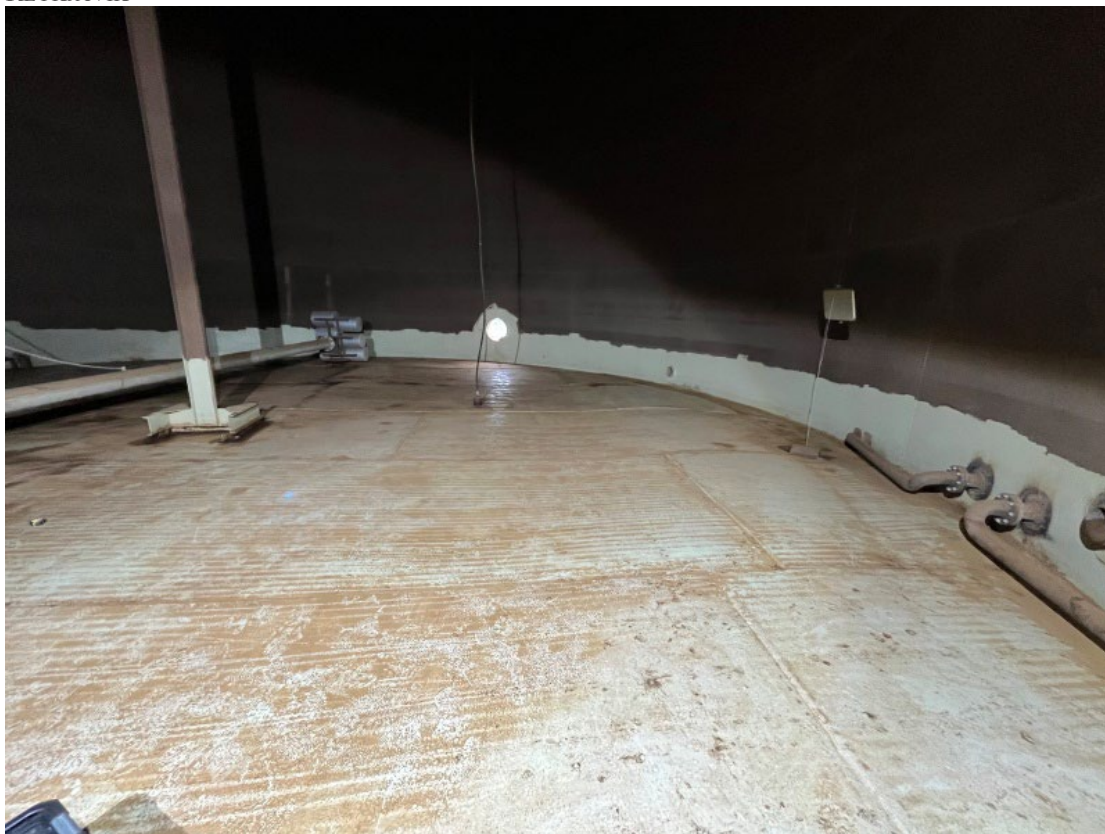
Mynd 3. Gólf og umfar geymis.
