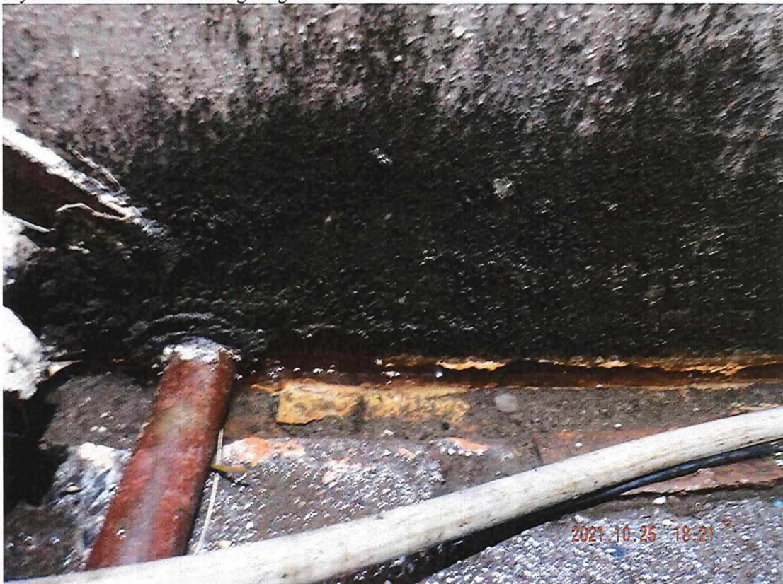
Mynd 10. Ástand málningar er misjafnt við kverk geymis og ryð farið að myndast víða án verulegrar tæringar.
