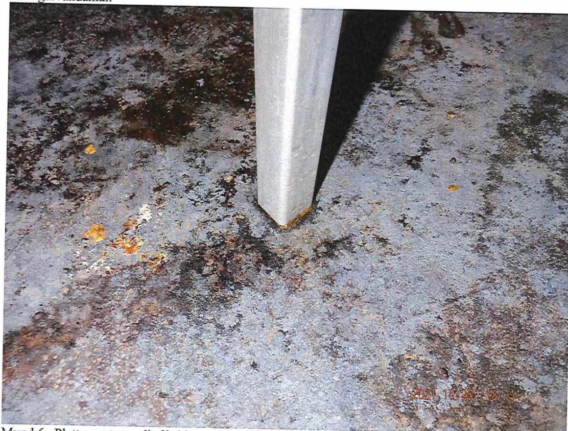
Mynd 6. Platta vantar undir fót hitaspírala.
