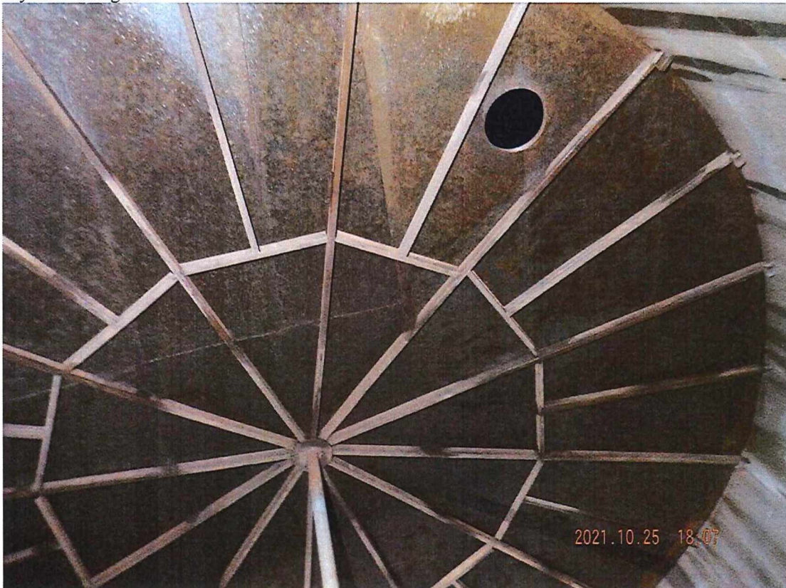
Mynd 4. Þak geymis.
