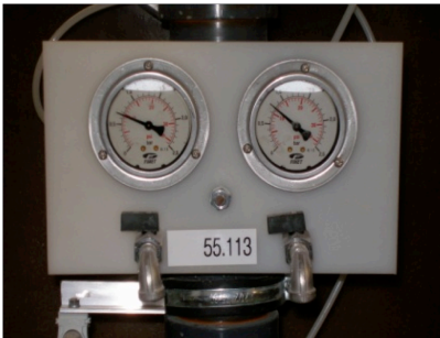
Mynd 2: Mælaplata síu með sýnitöku krönum. Sandsía í rekstrarstöðu
