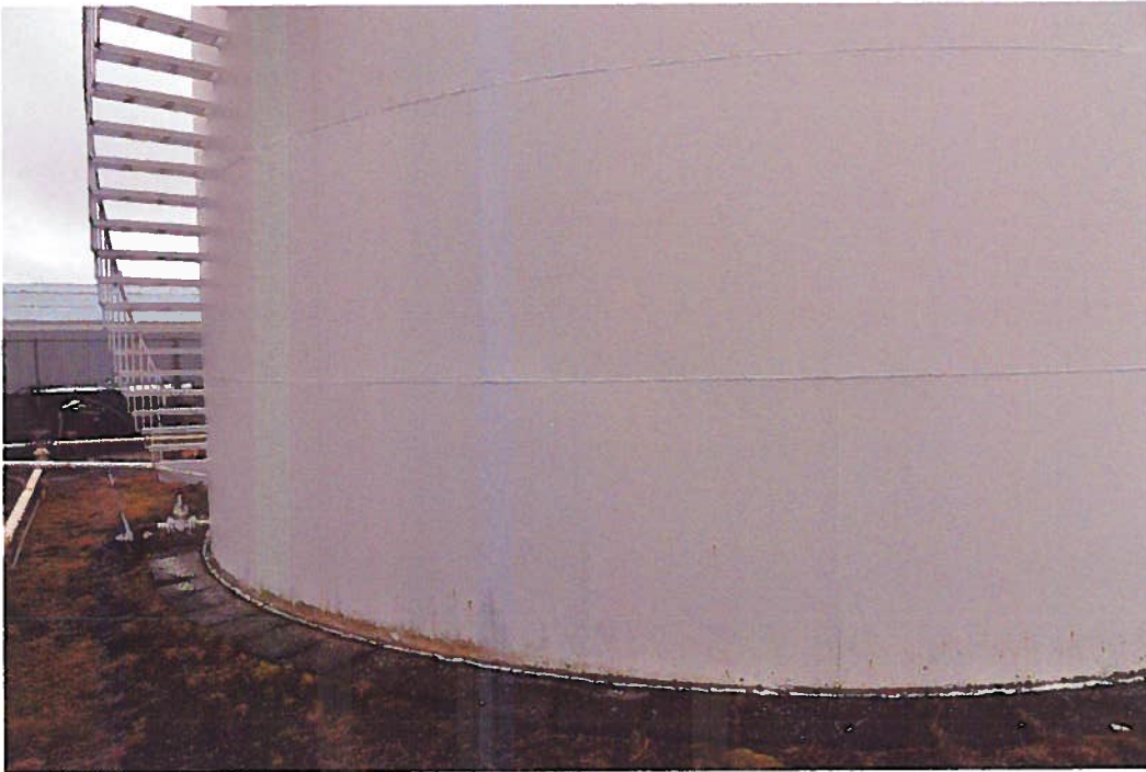
Geymir er málaður að utan og er ástand hennar ásamt stáli mjög gott.
