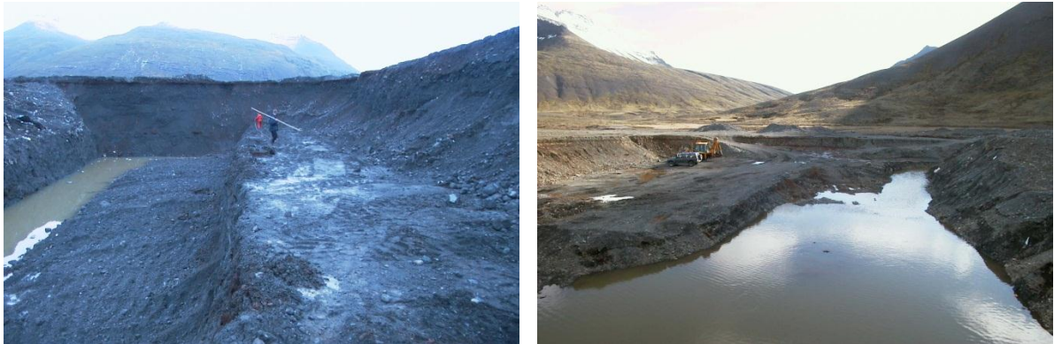
Mynd 6 Urðunarhólf í undirbúningi á urðunarstaðnum Lóni, séð beggja megin frá á mismunandi tíma.
