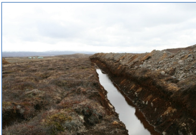
Mynd 19 Drenskurður vestan við fyrirhugað framkvæmdasvæði. Skurðurinn var grafinn til að veita vatni frá fyrirhuguðu framkvæmdasvæði. Legu skurðarins má sjá á mynd 20.
