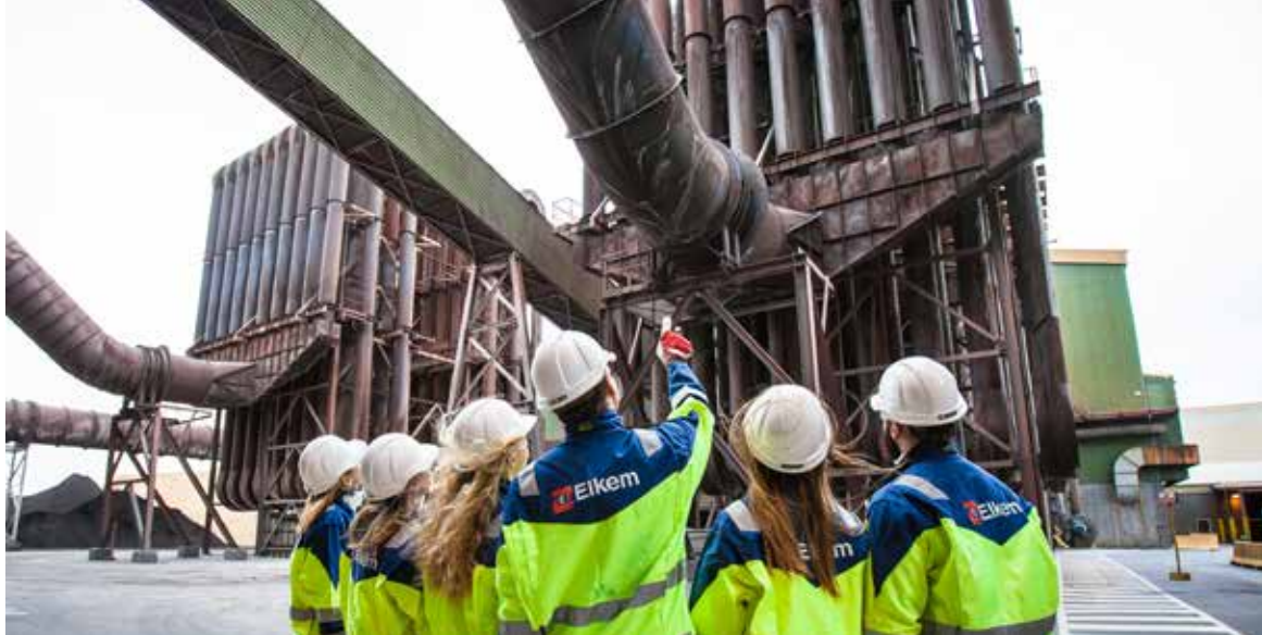
Reykhreinsivirki Elkem Ísland. Árlega fanga virkin um 20.000 tonn af kísilyrki sem notað er sem íblöndunarefni í sement.
