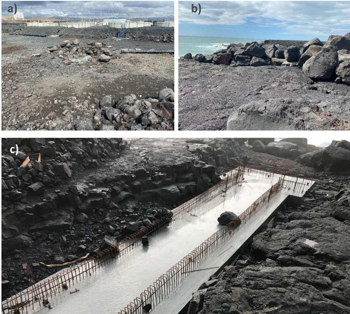
MYND 3-3 Eystri fráveita frá eldisstöð Íspórs. Fráveitan er niðurgrafin nema við fiskigildru (mynd a) og útrás í viðtaka (mynd b). Frá fiskigildru og að útrás í sjó liggur fráveitan í steyptum stökk, svokölluðum hamarshaus. Á mynd c) má sjá grunninn sem hamarshausinn var steypur á. Hann er nú hulinn jarðvegi og stórgrýti (sjá mynd a og b).
