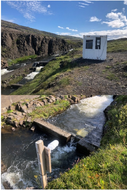
Mynd 5.6.8. Fiskistigi og myndatökubúnaður í Laugardalsá rétt fyrir ofan ós árinna.
