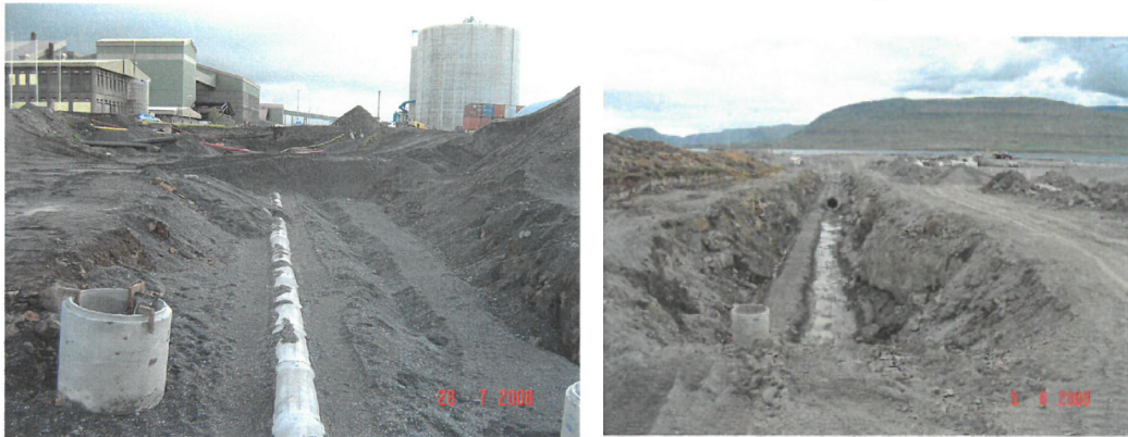
Mynd 4 Hægra megin sést lagnaskurður í götu, neðan við lóðina. Vinstra megin sést fyrirkomulag fráveitulagna í skurði (Myndir: Faxaflóahafnir)
