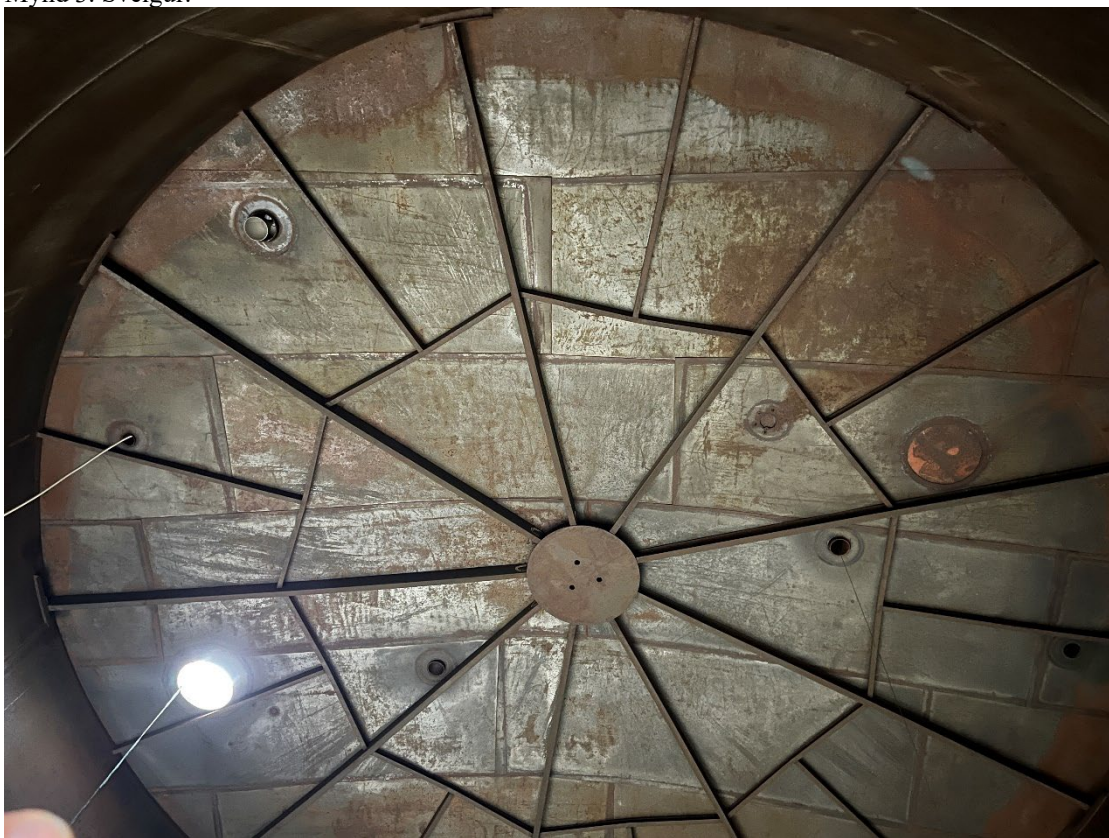
Mynd 4. Þak geymis.
