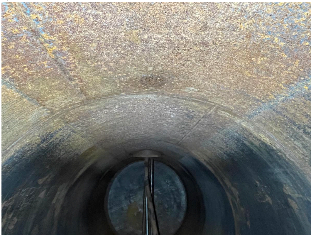
Mynd 3. Loft umfars er þakið ryðslykju en óveruleg tæring.
