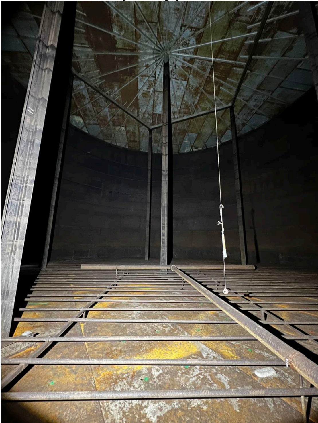
Mynd 1. Þak, gólf og umfar geymis.
