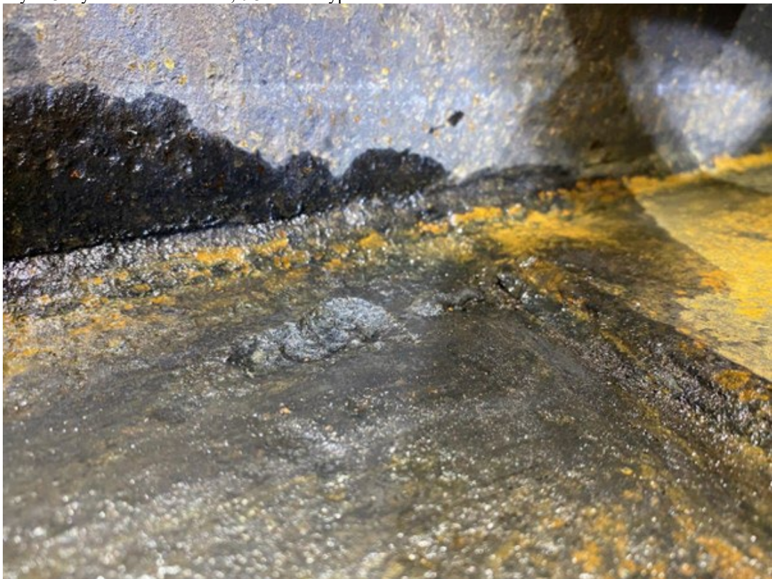
Mynd 4. Tæringapyttur á plötu 3 sem nær 3,5 mm að dýpt. Lagað að viðgerðarteymi Olíudreifingar. Einnig sést kantsár vel. Slíkt kantsár er einnig við plötu 8.
