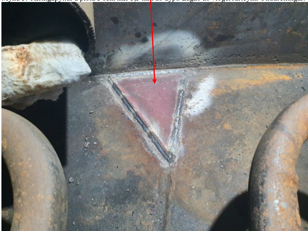
Mynd 6. Tæringapyttur á plötu 3 sem nær 3,5 mm að dýpt. Lagað að viðgerðarteymi Olíudreifingar.
