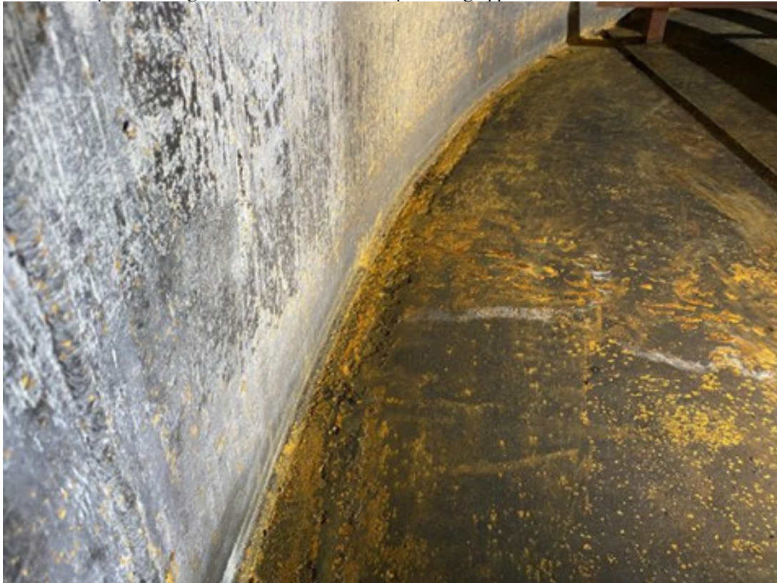
Mynd 7. Þessi mynd sýnir langt svæði sem er um 4 metrar á lengd í kverkinni þar sem botnplötur 8 og 6 mætast neðstu umfarsplötu nr 4.
