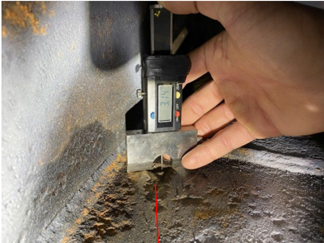
Mynd 5. Tæringapyttur á plötu 3 sem nær 3,5 mm að dýpt. Lagað að viðgerðarteymi Olíudreifingar.
