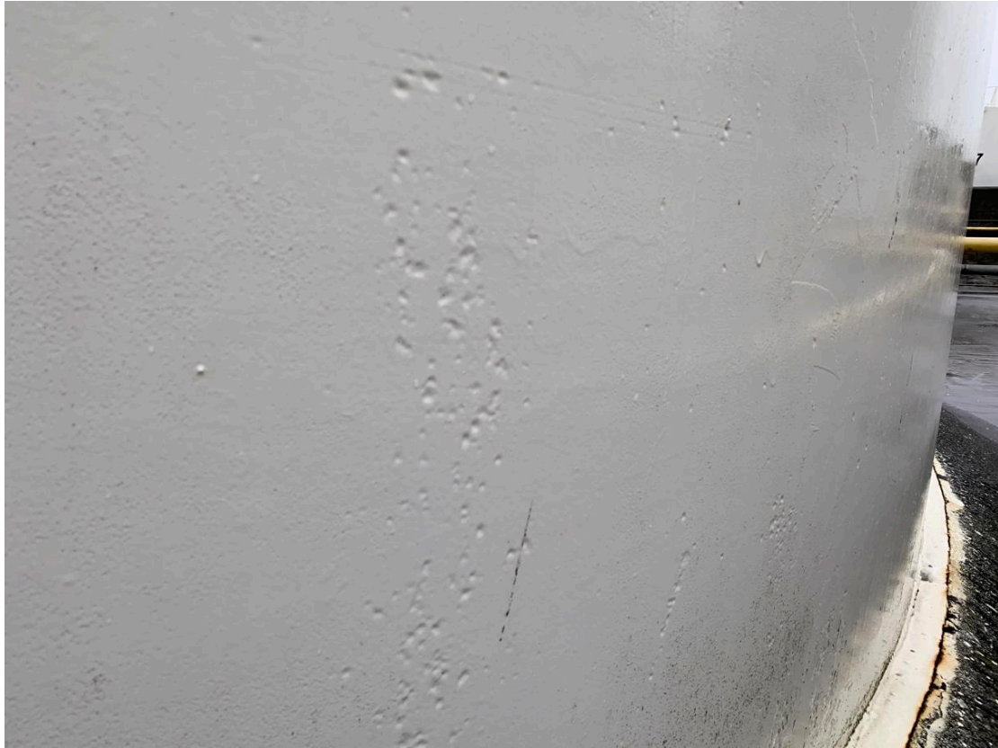
Mynd 7. Víða má finna rúmlega 0,5-1,5 mm djúpa pytti utanvert.
