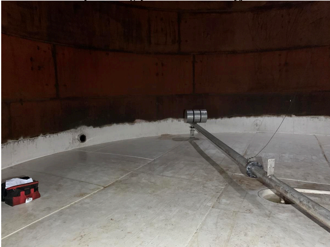
Mynd 1. Gólf er málað ásamt hluta af neðsta umfari. Ástand málningar er gott
