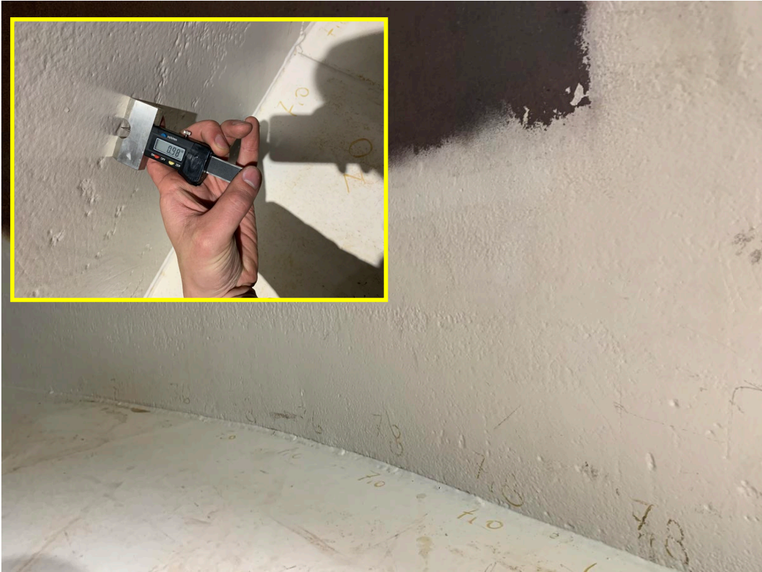
Mynd 6 og 7. Geymir er í góðu ástandi. Tæring frá fyrri tíð sést vel.
