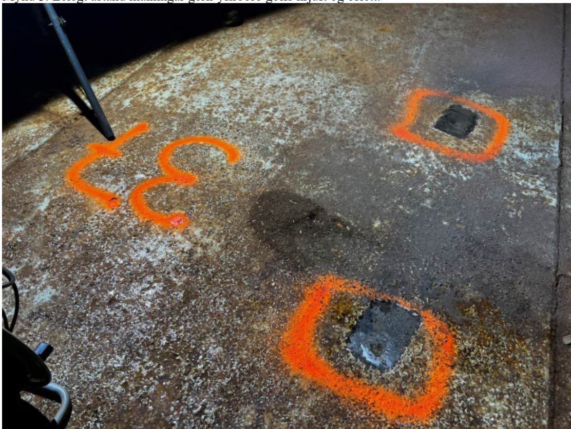
Mynd 4. Nokkrir staðir fundust í geymi sem þörfuðust nánari skoðunar. Einn bletturinn reyndist hafa 3.4mm í efnisþykkt sem er yfir viðmiðunarmörkum. Aðrir blettir voru um 5mm.
