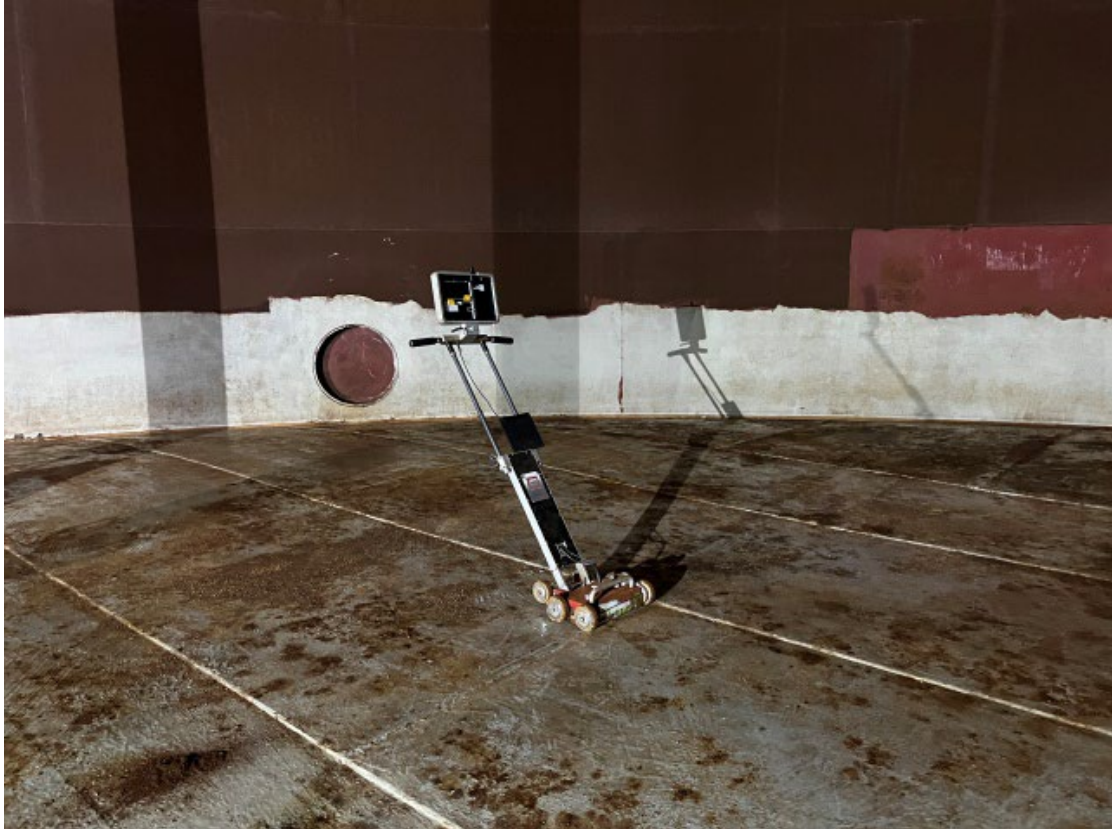
Mynd 2. Gólf og umfar geymis.
