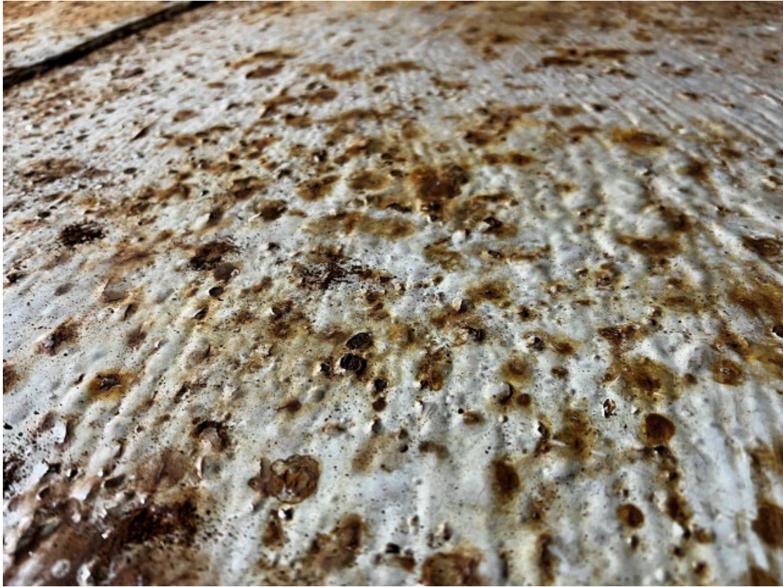
Mynd 3. Lélegt ástand málningar gerir yfirborð gólfs hrjúft og óslétt.
