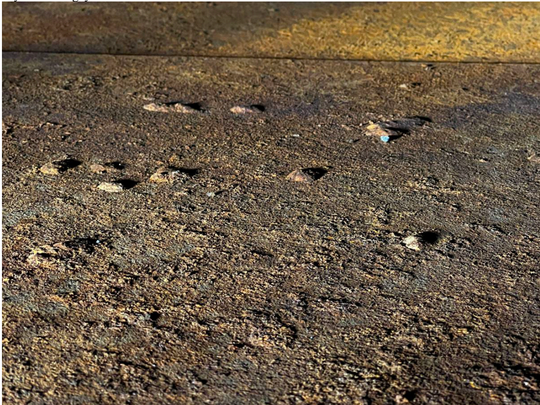
Mynd 2. Víða um geymin er búið að sjóða stutta suðustrengi.
