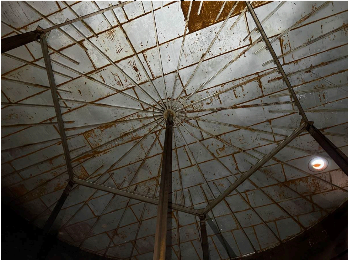
Mynd 1. Þak geymis.
