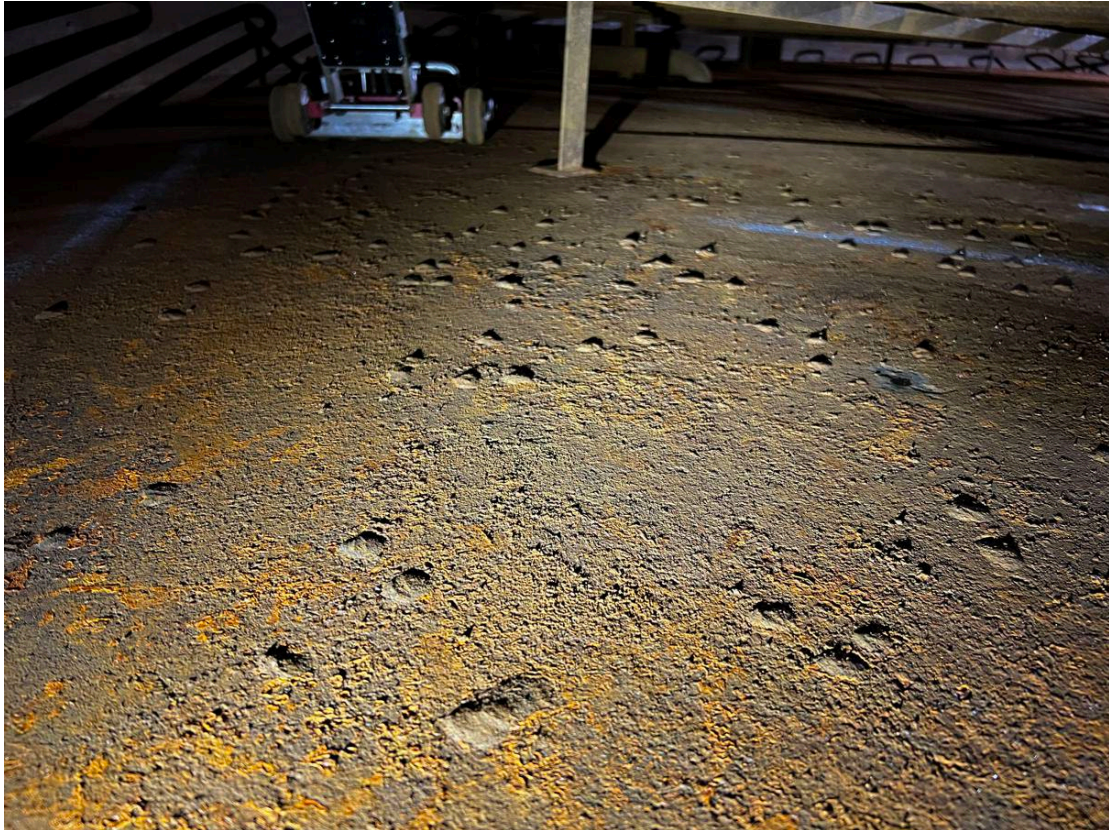
Mynd 3. Víða um geymin er búið að sjóða stutta suðustrengi.
