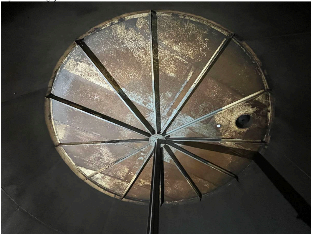
Mynd 2. Þak geymis.
