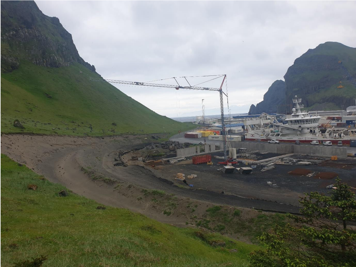
MYND 2.4 Yfirlitsmynd yfir lóð seiðældis í Friðarhöfn. Fyrir miðri mynd má sjá grjótvarnargarð sem gerður var til að draga úr hættu sökum grjótgruns frá Klifinu. Mynd: ILFS
