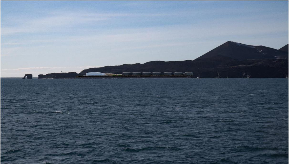
MYND 4.17 Myndatökustaður við innsiglingu. Mannvirkjum í tengslum við framkvæmdir í Viðlagafjöru hefur verið varpað á myndina Byggingar, plön kerjapalla og jarðefnalager má sjá fyrir miðri mynd. Gögn : ILFS og EFLA
