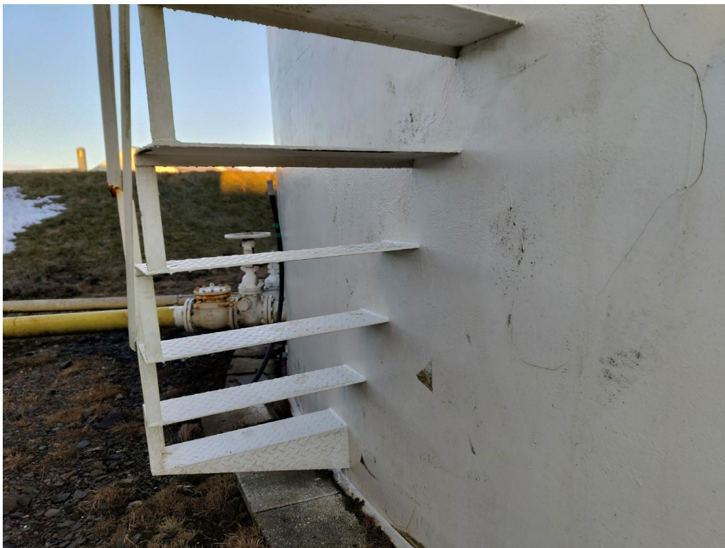
Mynd 2. Ástand málningar gott þó stöku sprungur séu.
