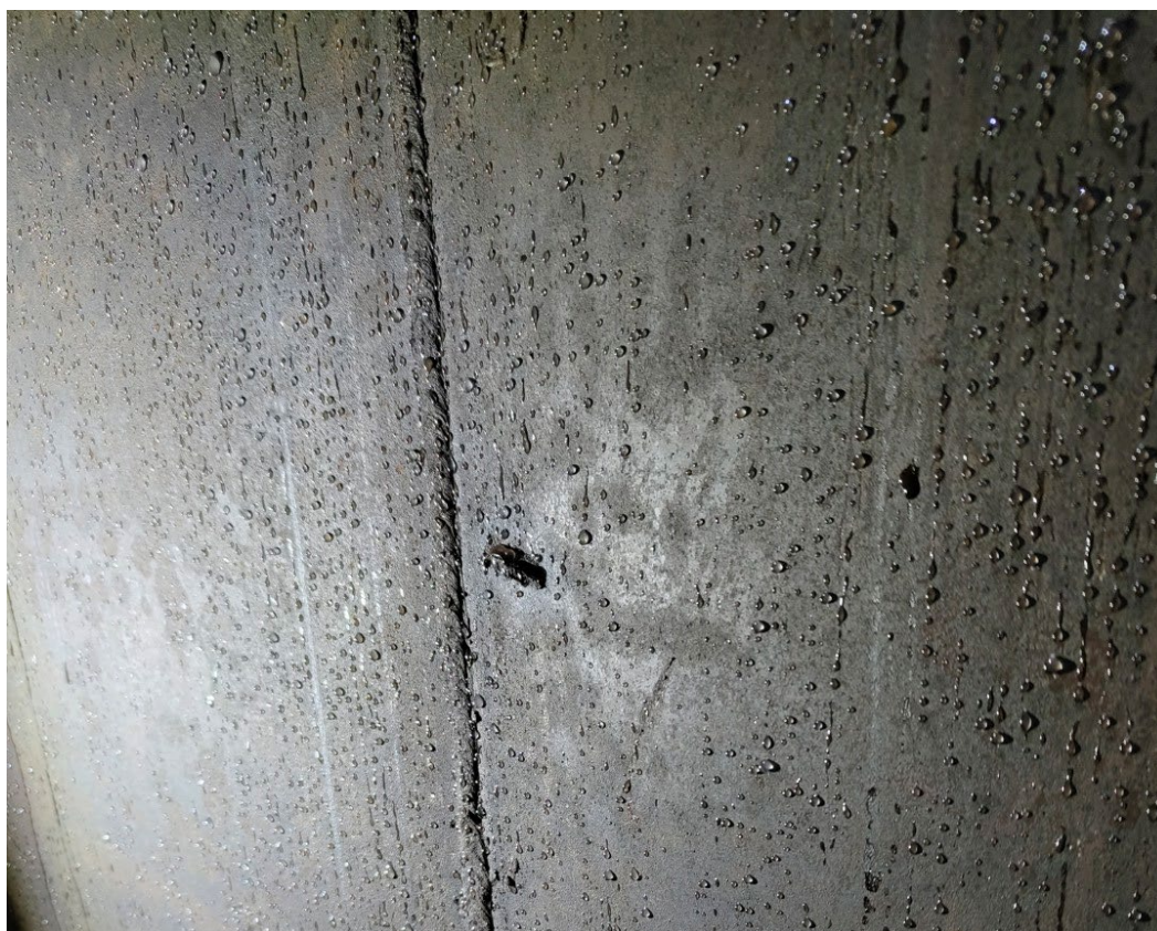
Mynd 11. Veggir/umfar tanks. Yfirborð er sem nýtt og engar athugasemdir.
