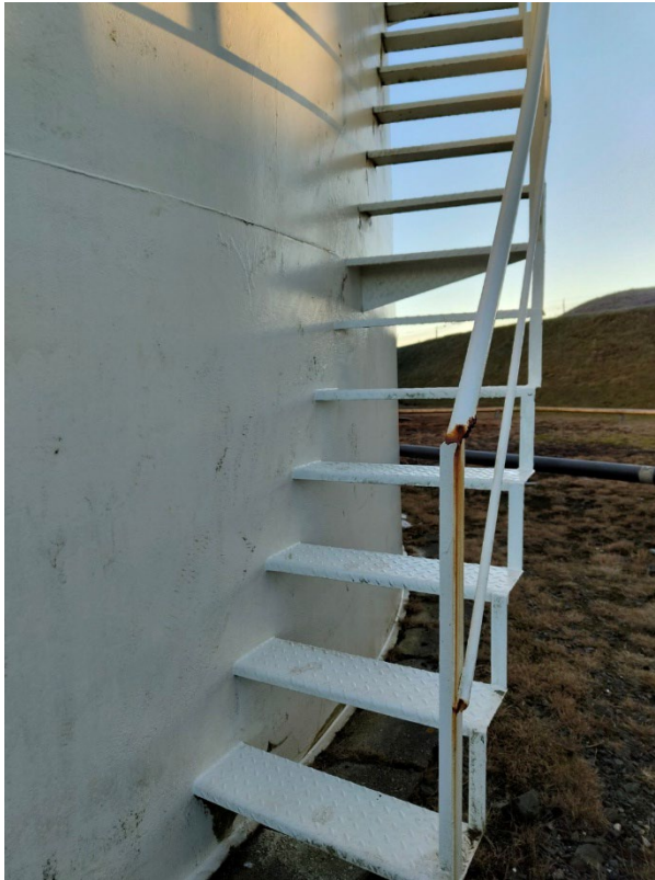
Mynd 1. Tankur séður utan frá. Ástand málningar heilt yfir mjög fínt.
