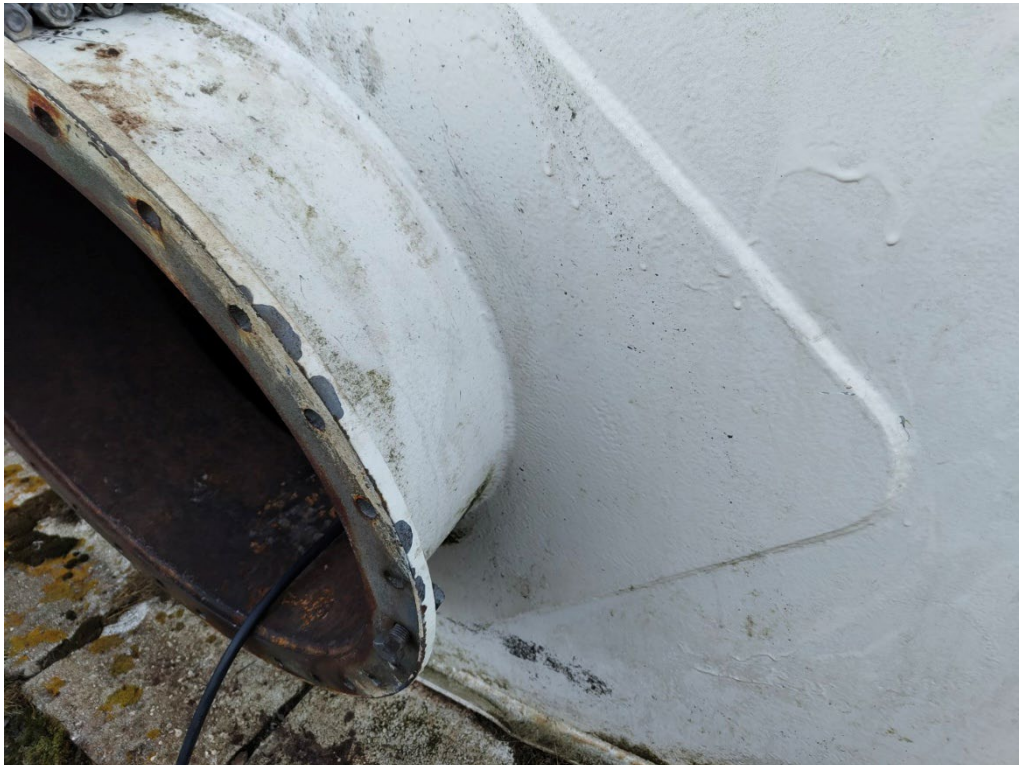
Mynd 4. Flangs og styrking í mannopi hrein og fin.
