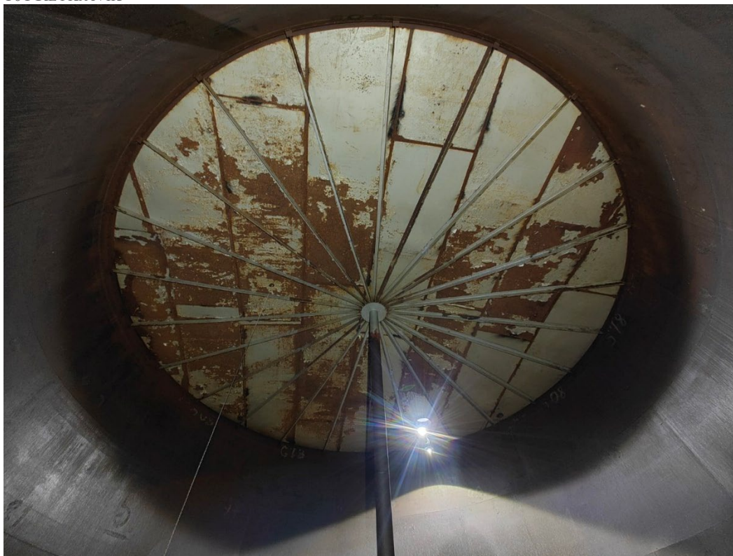
Mynd 5. Óveruleg yfirborðs tæring í lofti geymis.
