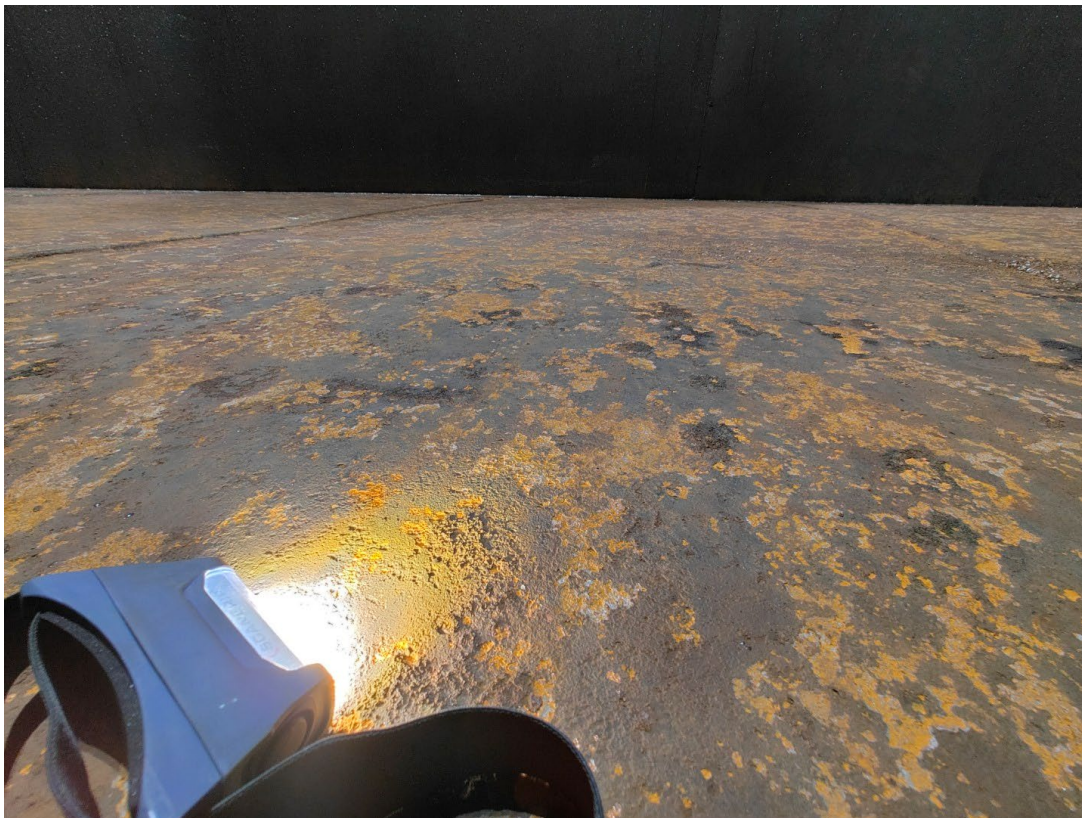
Mynd 7. Að öðru leiti er yfirborð gólfs nokkuð gott þótt stöku skellur leynist hér og þar með pyttum þá eru þeir grunnir.
