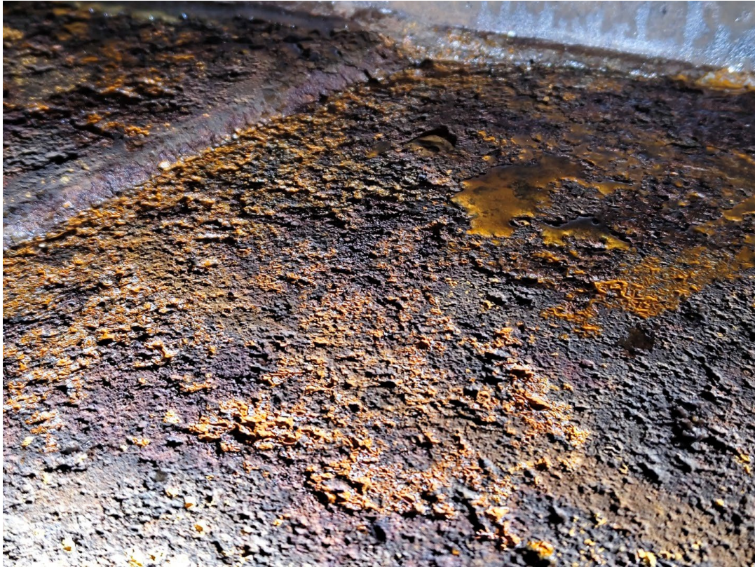
Mynd 6. Yfirborð nokkuð hrjúft innst v.megin þegar horft er inn um mannop. litlir pittir á 1x0.5m svæði sem ná 1-1.5mm dýpt
